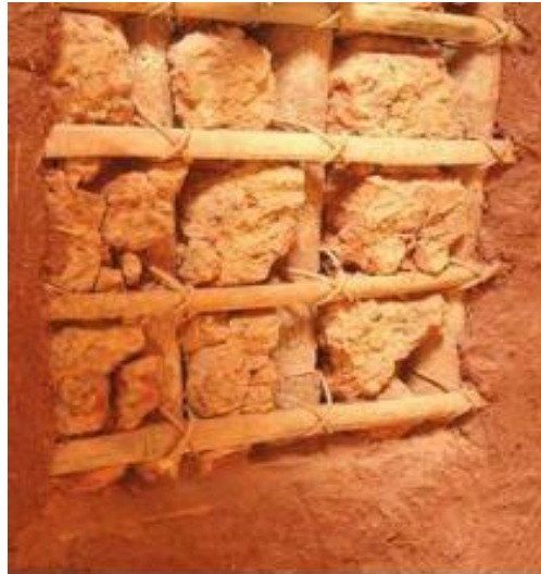
Figura 4 - Detalhe da parede de taipa de mão
