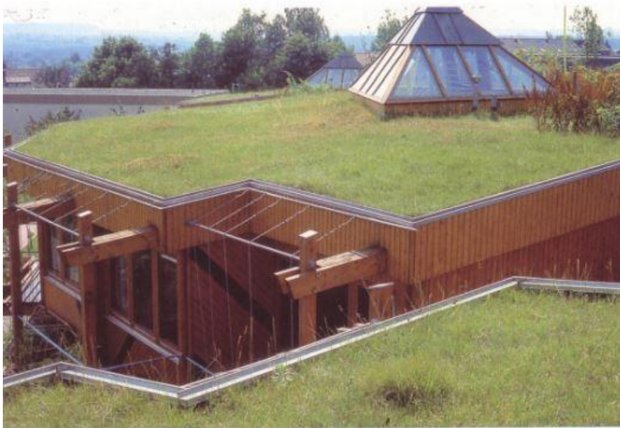
Figura 10 - Telhado verde plano
