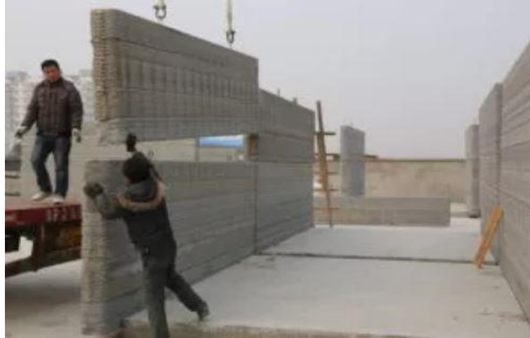
Figura 6 - Edificação construída usando impressão 3D
