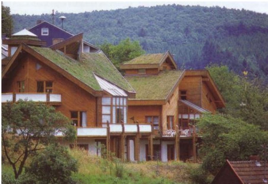
Figura 11 - Telhado verde inclinado
