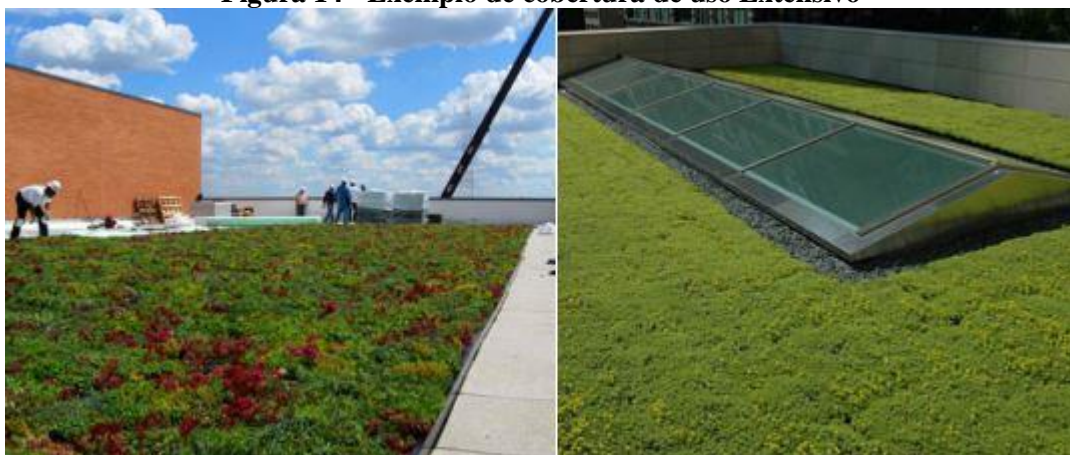
Figura 14 - Exemplo de cobertura de uso Extensivo
