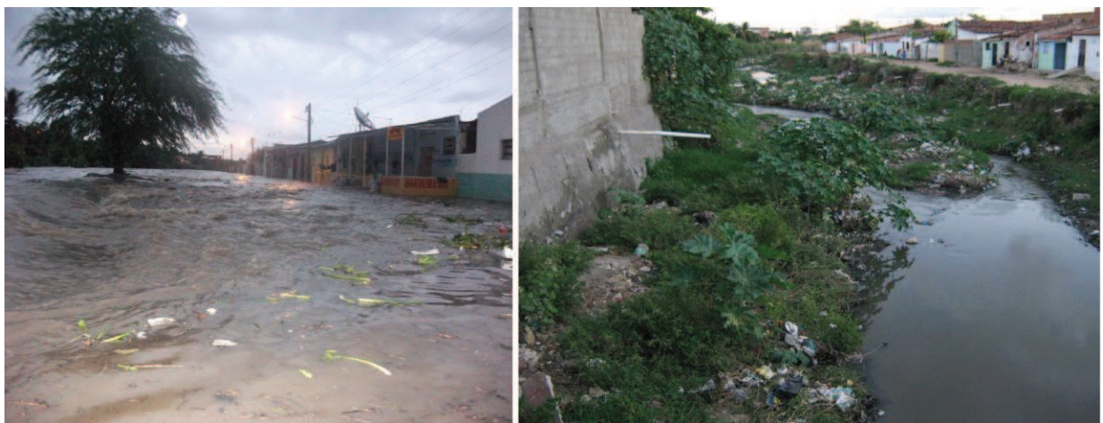
Figura 06 Rua Fortaleza. Bairro Santa Cruz, em dois momentos: Fevereiro de 2011 e Junho de 2012.
