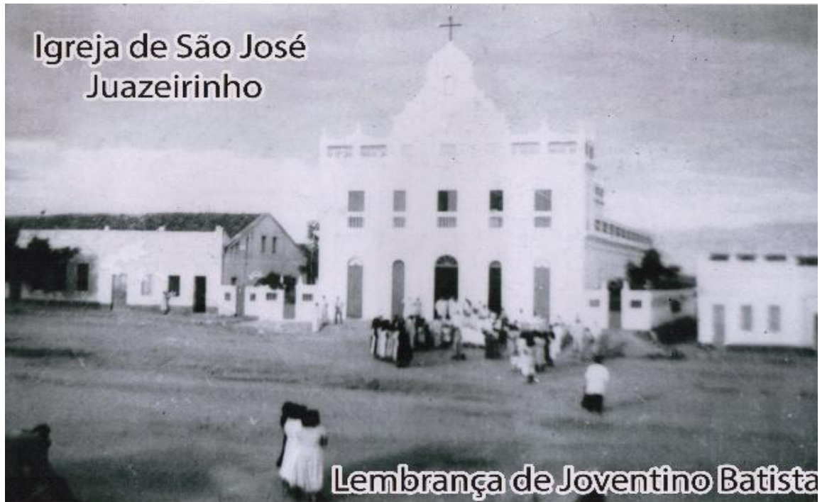
FIGURA 3: Fachada da igreja de São José, Juazeirinho. Sem data
