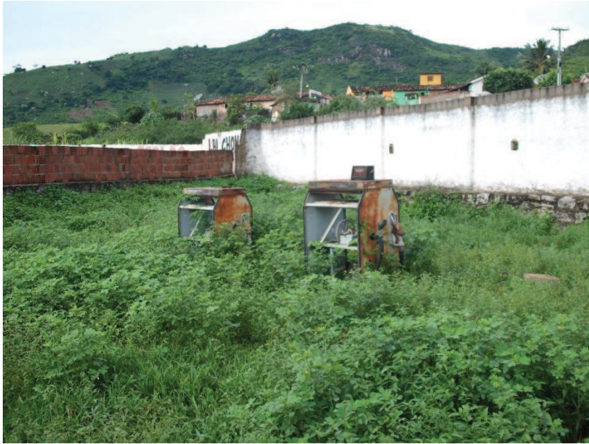
Figura 06: Bombas de combustível desativadas. Maio/2009. Fonte: Ismara Brito.
