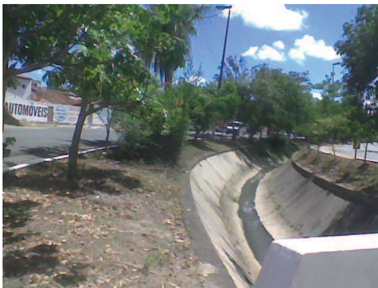
Foto 1. Canal situado na Av. Cajazeiras próximo a Rua da Escola.
