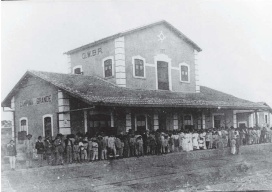
Figura 02: Estação ferroviária inaugurada no ano de 1907 em Campina Grande-PB.
