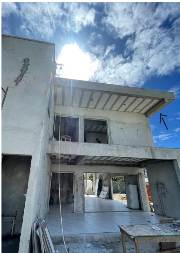
Figura 47 – Fachada posterior executada.
