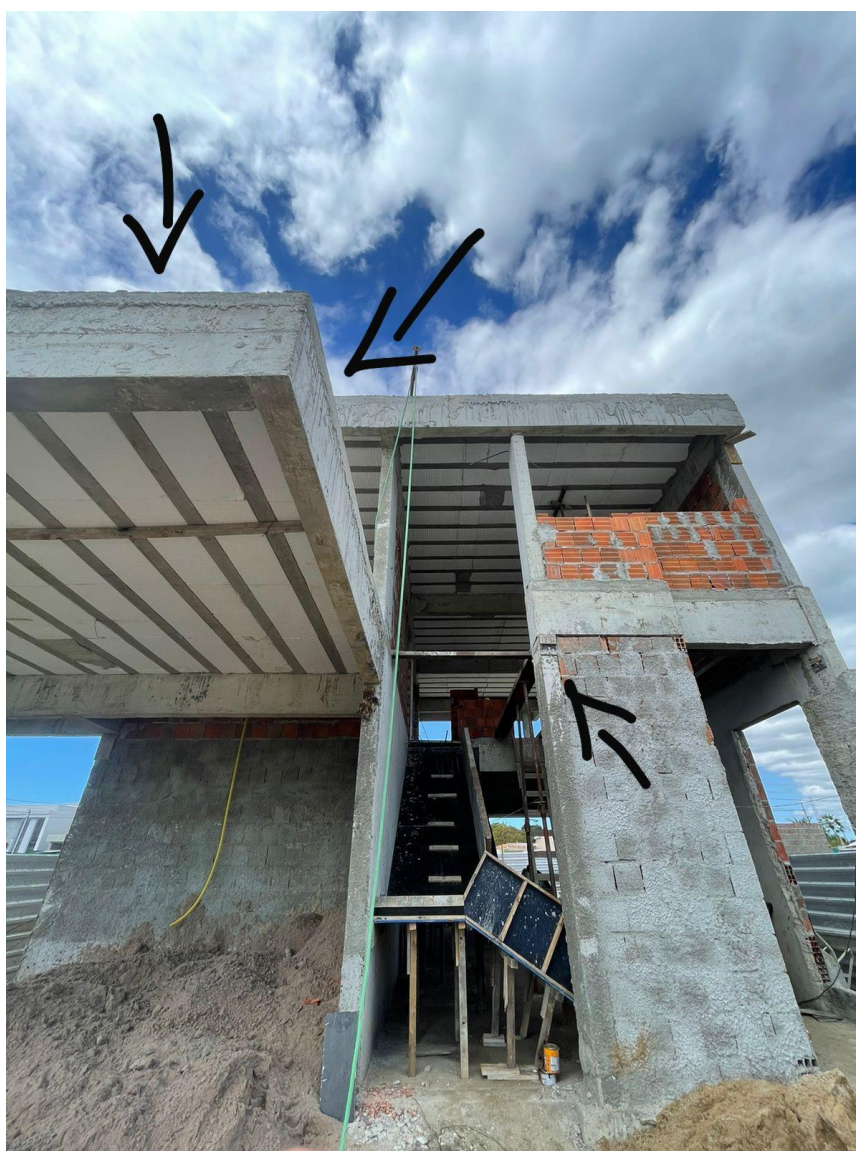
Figura 59 – Execução da fachada frontal da Obra 02.
