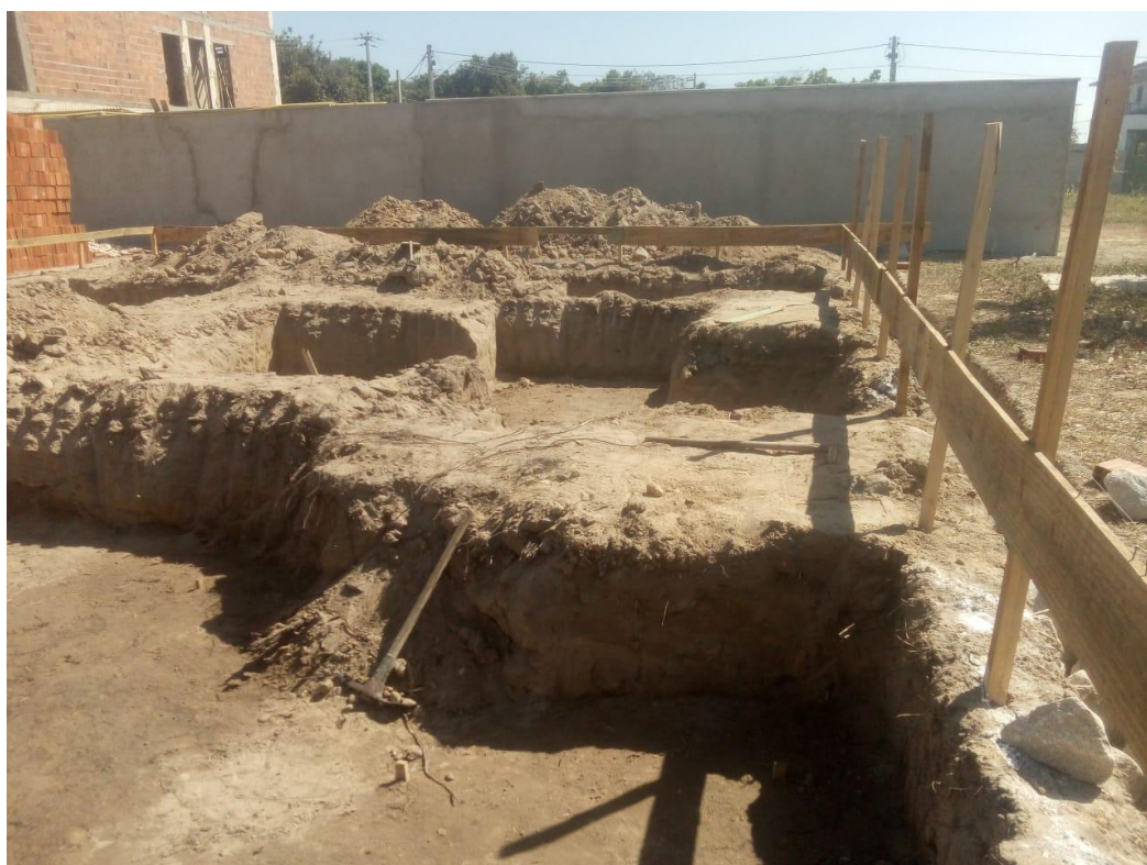
Figura 39 – Escavação manual das bases de fundação.
