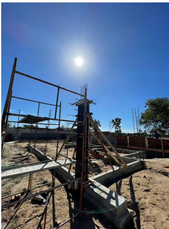
Figura 40 – Viga baldrame totalmente concretada.
