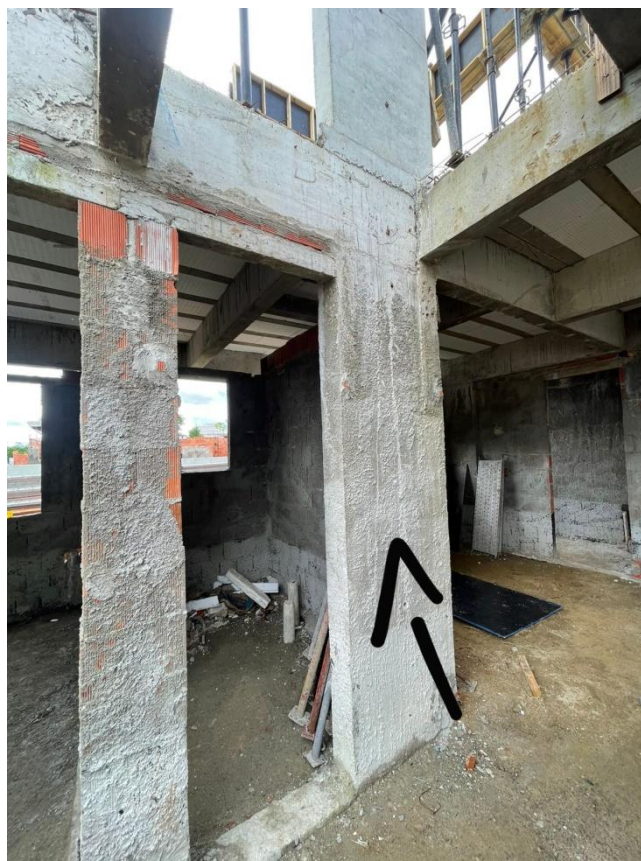
Figura 63 – Execução de um pilar que coincide na localização de tomadas e interruptores.
