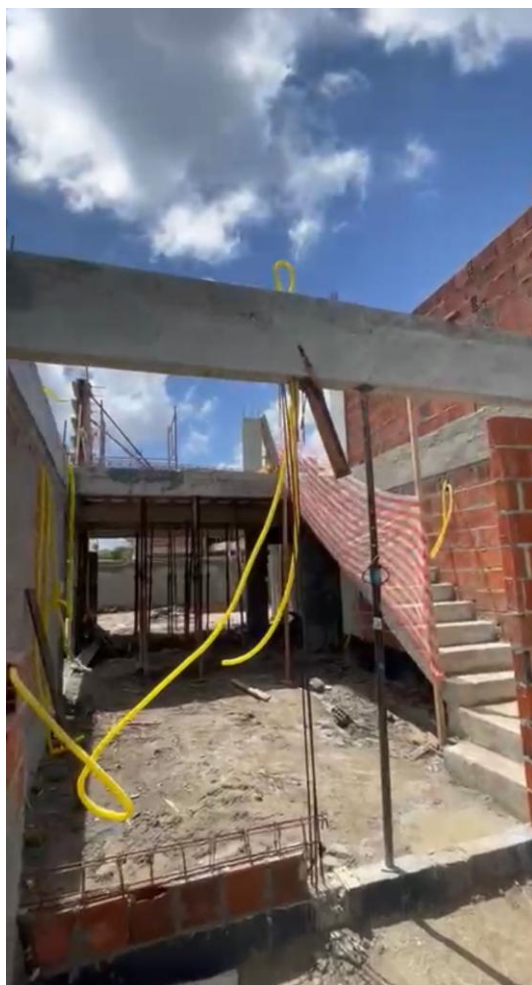
Figura 43 – Viga V9 executada.
