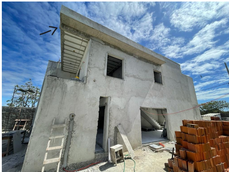
Figura 46 – Fachada lateral executada.
