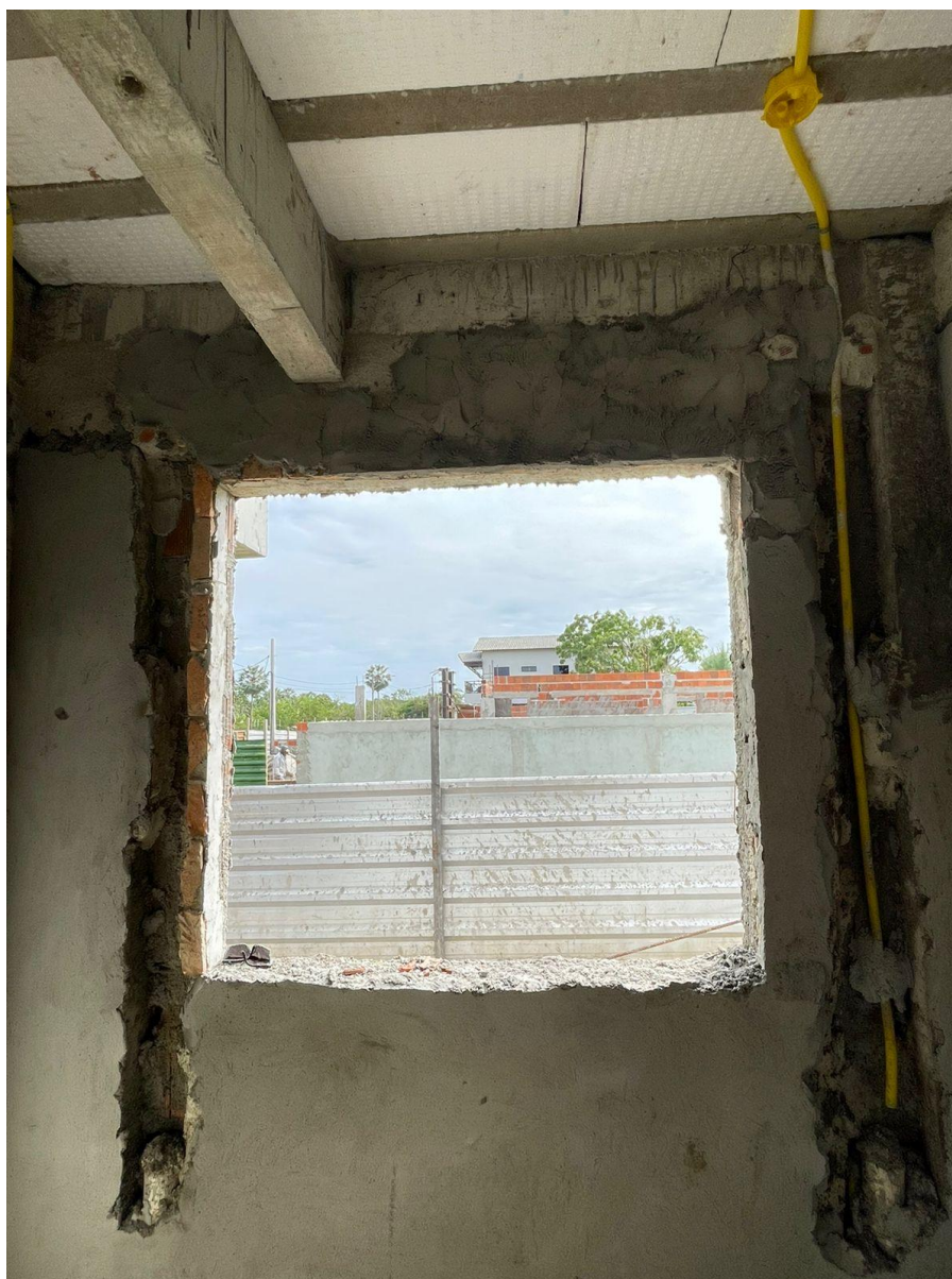
Figura 64 – Execução de alvenaria e viga, onde passariam tubulações de esgoto.
