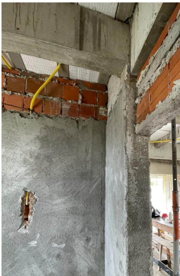
Figura 60 – Largura das alvenarias da Obra 02.
