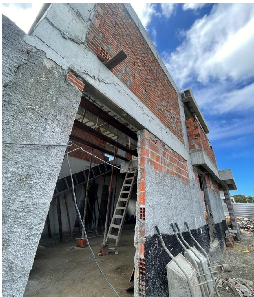
Figura 65 – Fachada lateral esquerda executada da Obra 02.
