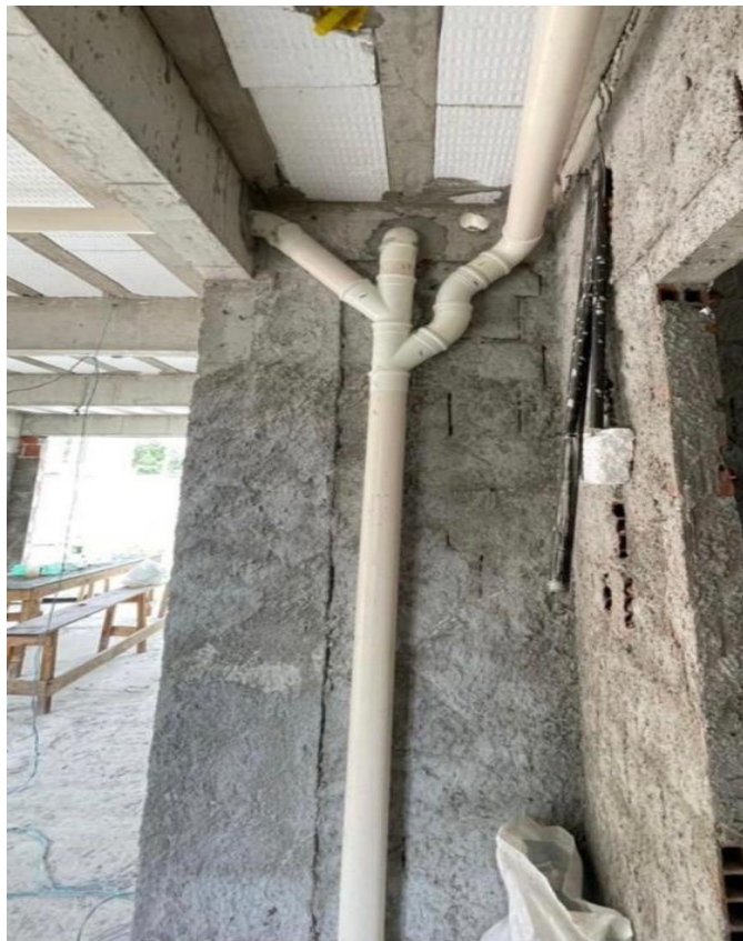
Figura 45 – Local onde foi executado a criação do Shaft .
