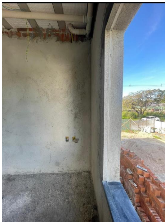
Figura 44 – Largura das alvenarias da Obra 01.
