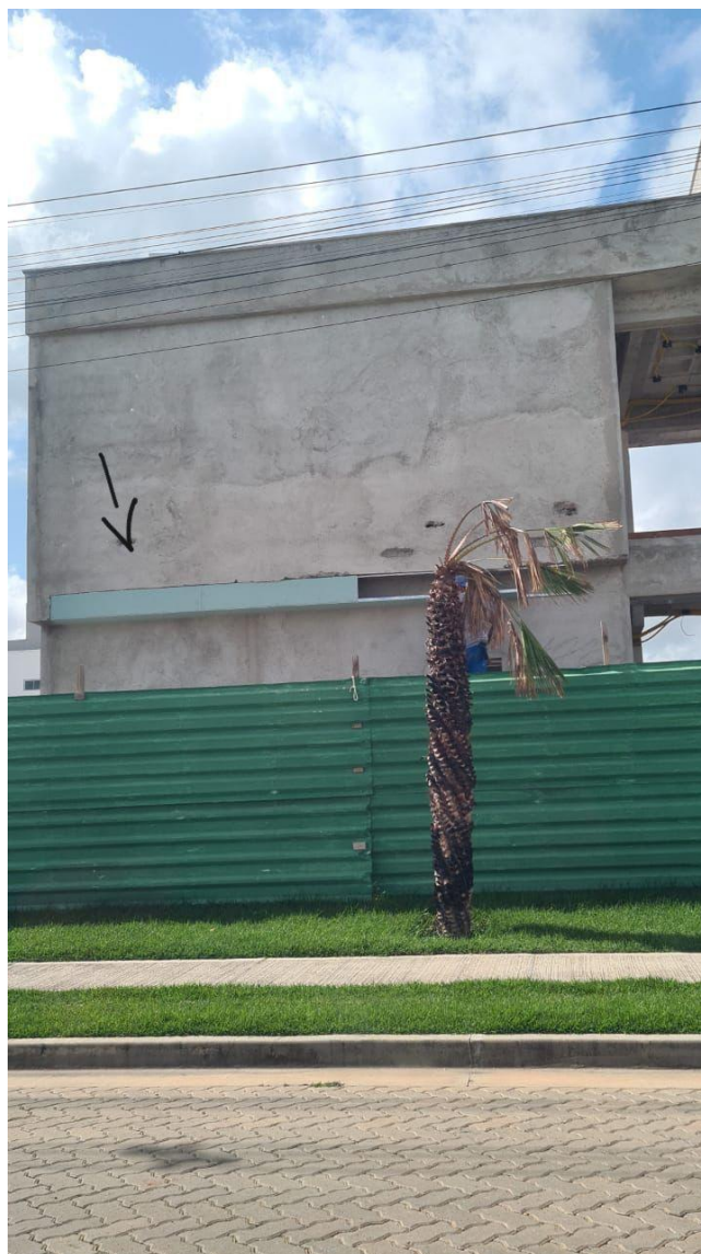
Figura 48 – Exemplo de utilização de gesso hidrofugado em fachadas.
