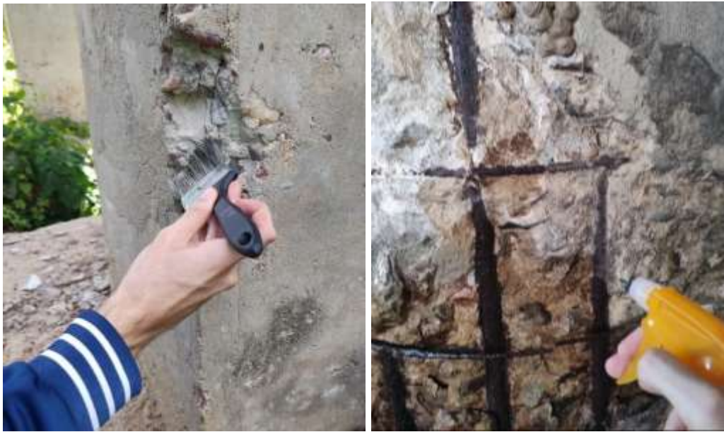
Figura 28 – Procedimento para medição da profundidade de carbonatação, a) Limpeza da região estudada, b) Aspersão de fenolftaleína
