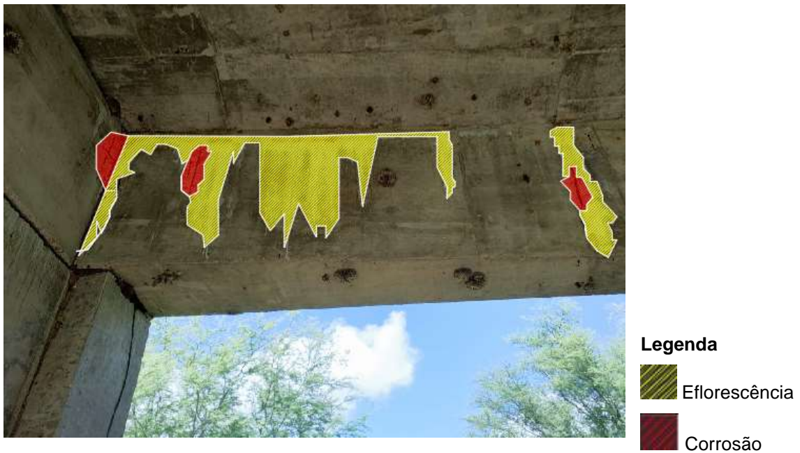
Figura 33 – Hachura destacando as manifestações patológicas observadas na Figura 32
