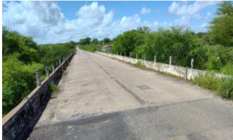
Figura 26 – Vista geral da ponte do Umbuzeiro
