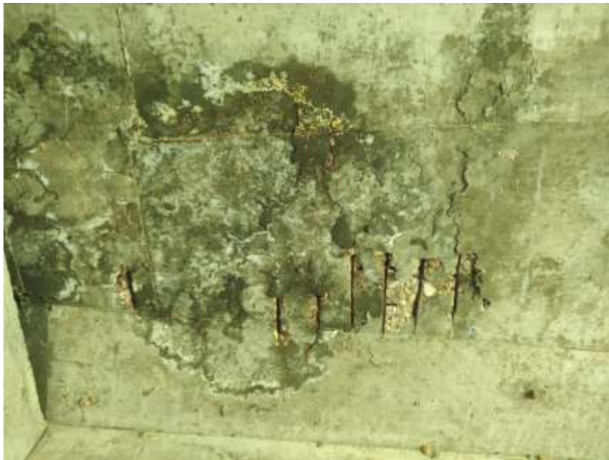
Figura 40 – Face inferior da laje do tabuleiro
