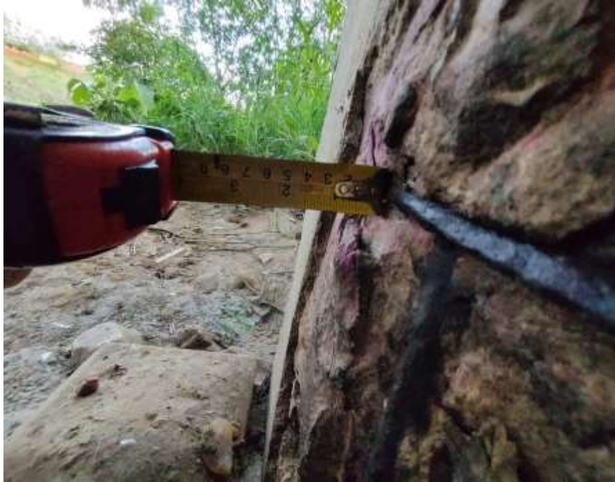
Figura 53 – Medição do cobrimento do concreto em pilar
