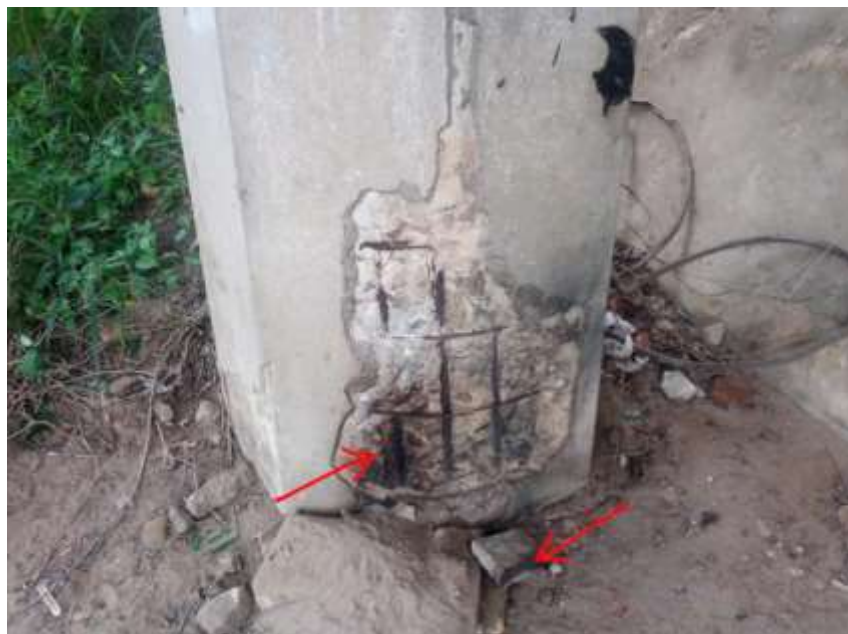
Figura 50 – Manchas escuras encontradas
