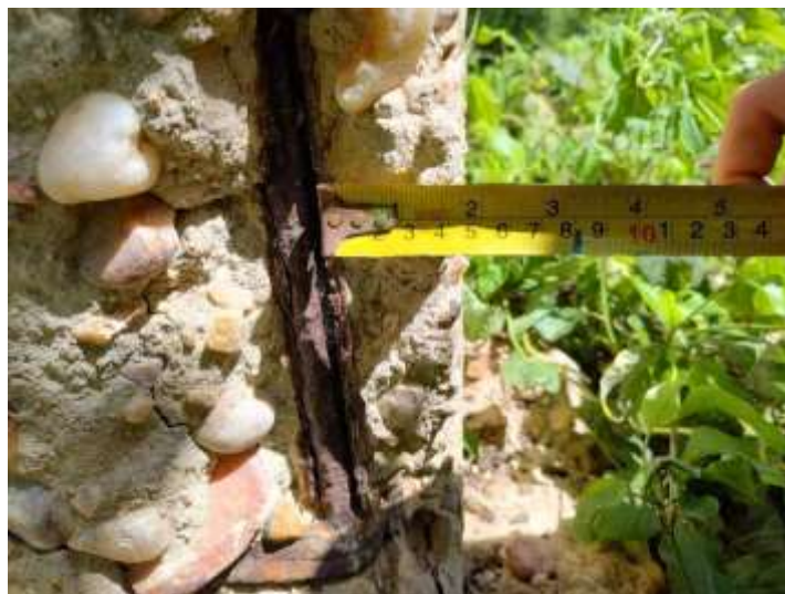
Figura 30 – Exemplificação da medição do cobrimento nos pilares
