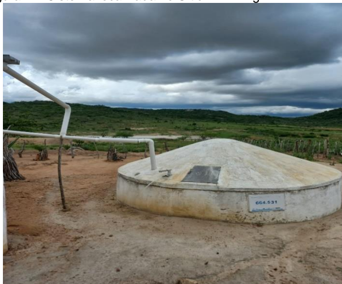
Figura 12: Cisterna localizada no Sítio olho d'água em Damião-PB
