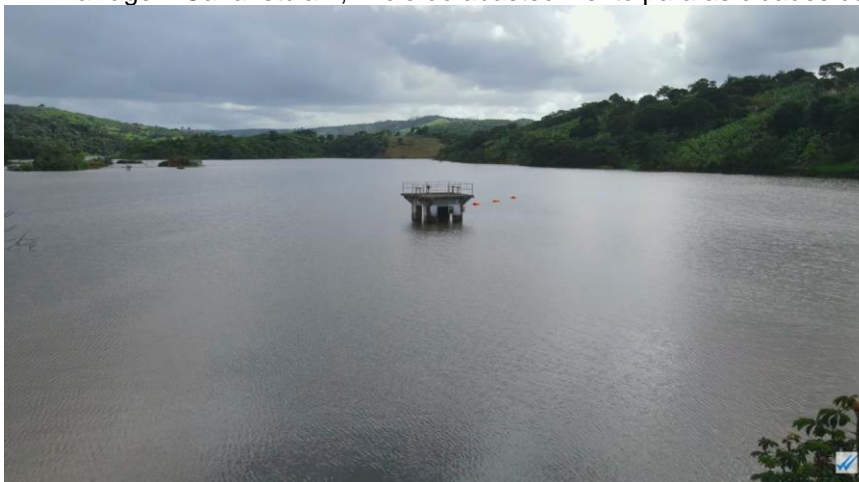
Figura 11 – Barragem Canafístula II, início do abastecimento para as cidades da região.
