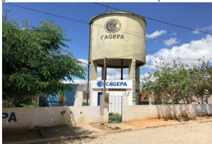
Figura 17 – Reservatório de elevado do município de Damião-PB
