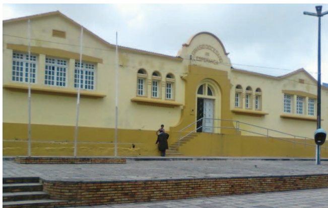
Figura 01: Vista da fachada da Escola M.E.F. Dom Manuel Palmeira da Rocha.
