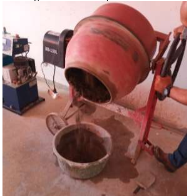
Figura 28 - Fabricação do concreto
