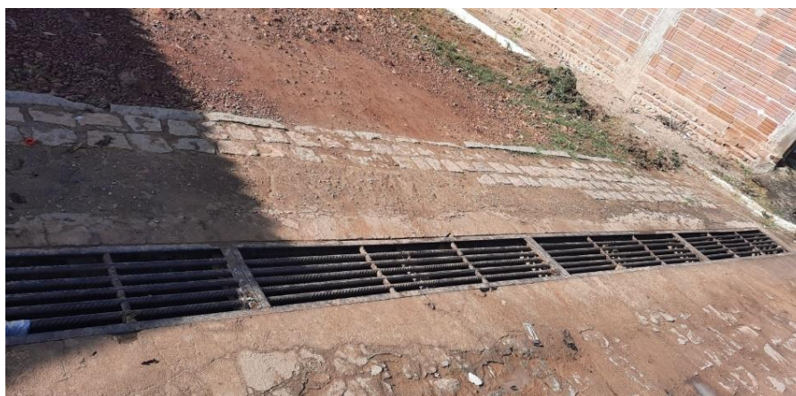
Figura 19 – Elemento de drenagem (boca de lobo) localizado na região 2
