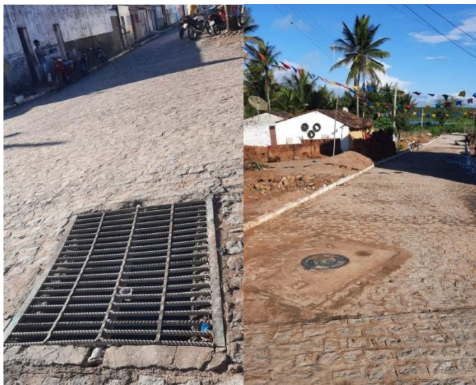
Figura 20 – Elementos de drenagem (boca de lobo e poço de visita) presentes na região 1
