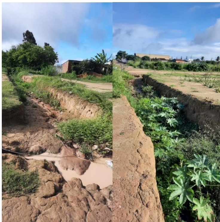
Figura 18 – Valas escavadas na região 2 para contenção da água da chuva
