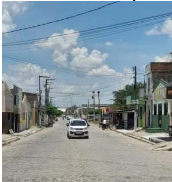
Figura 7: Avenida José Silveira no centro da cidade de Salgado de São Félix/PB.
