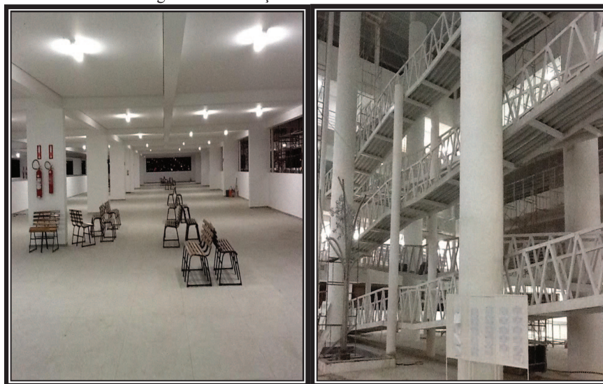
Figura 13- Instalações da Nova Central de Aulas
