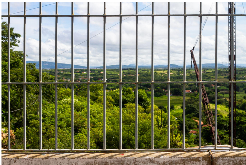
Figura 17 - Vista da casa de turbina
