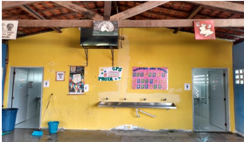
Figura 6 - Vista do bebedouro, na porção central da imagem, entre as portas dos banheiros.
