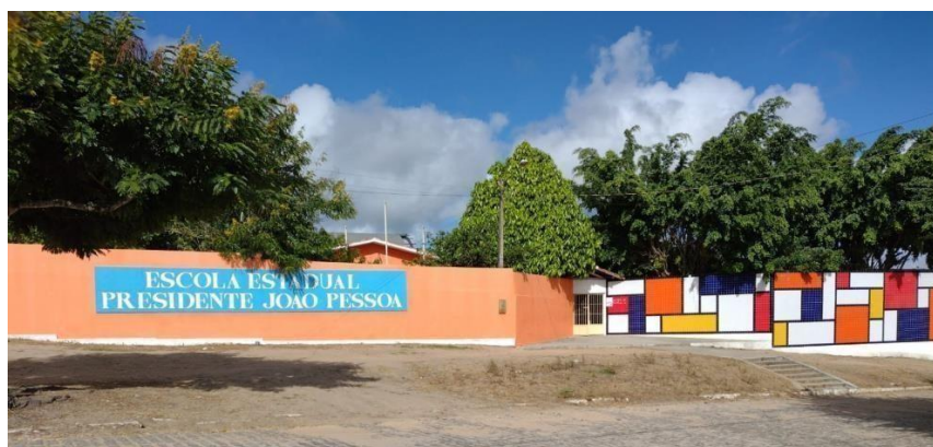
Figura 1: Fachada da Escola Cidadã Integral Técnica Presidente João Pessoa - ECIT.
