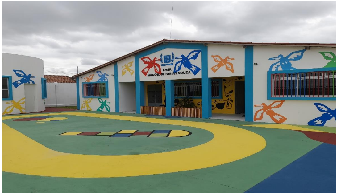
Figura 02: Fachada da Escola Manoel de Farias Souza
