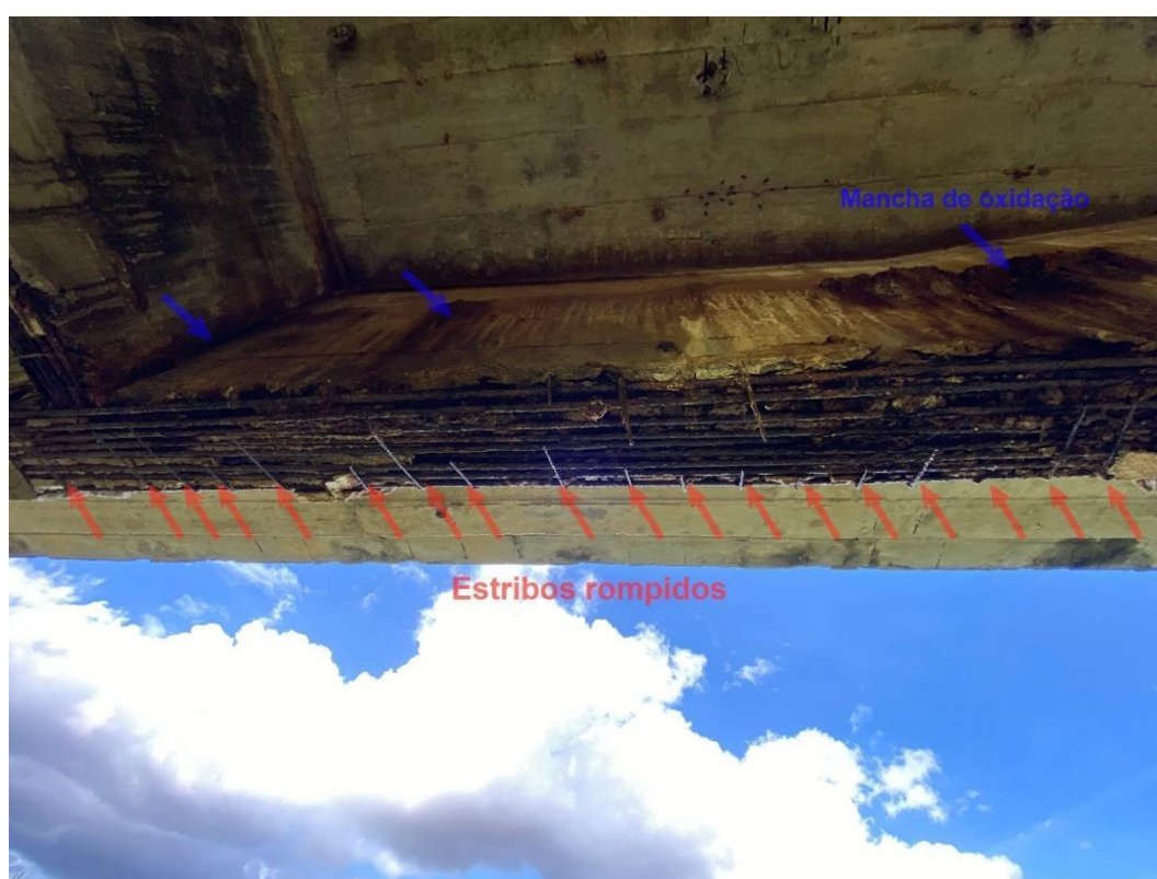
Figura 41 – Longarina entre o pilar P1 e P3
