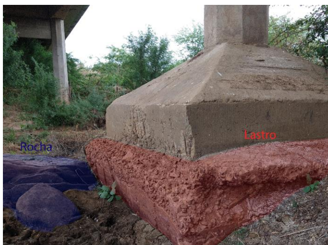
Figura 28 – Sapata apoiada sobre rocha sã
