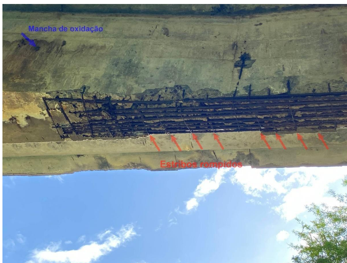
Figura 42 – Longarina entre o pilar P2 e P4
