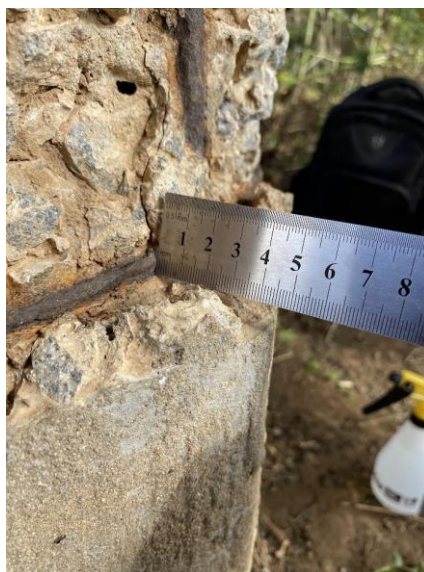
Figura 23 – Aferição do cobrimento em um pilar
