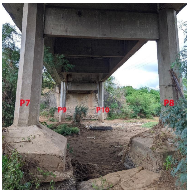
Figura 27 – Fundações dos pilares P7, P8, P9 e P10
