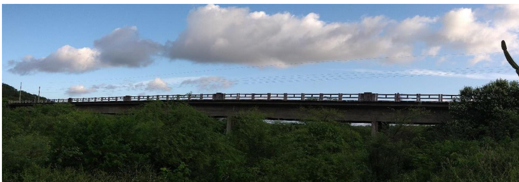
Figura 20 – Acesso para inspeção visual
