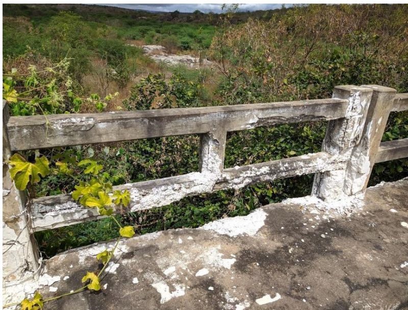
Figura 44 – Guarda-corpo deteriorado
