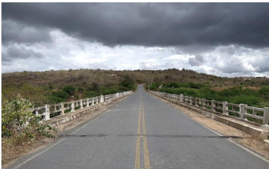
Figura 18 – Vista da ponte
