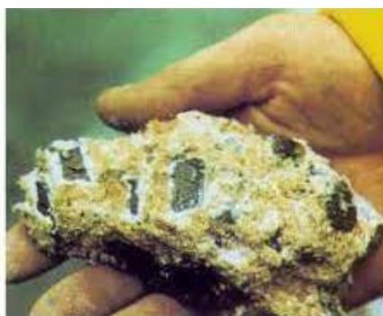
Figura 7 – Concreto sujeito ao ataque por sulfatos
