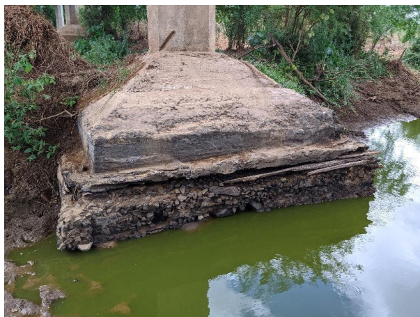
Figura 29 – Fundação do pilar P9
