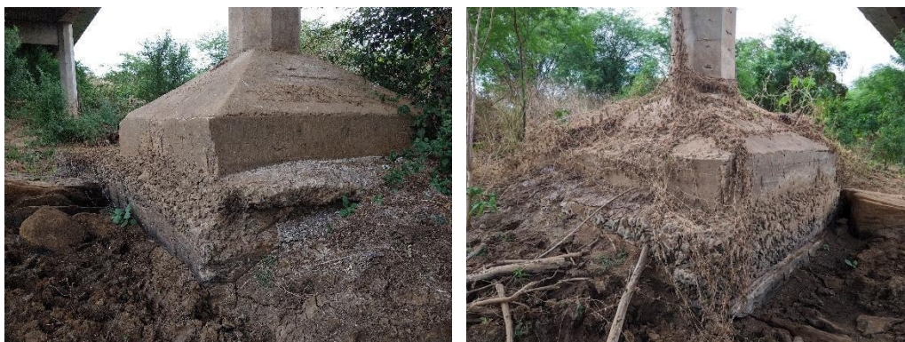
Figura 30 – Fundações dos pilares P7, P8 e P10, respectivamente
