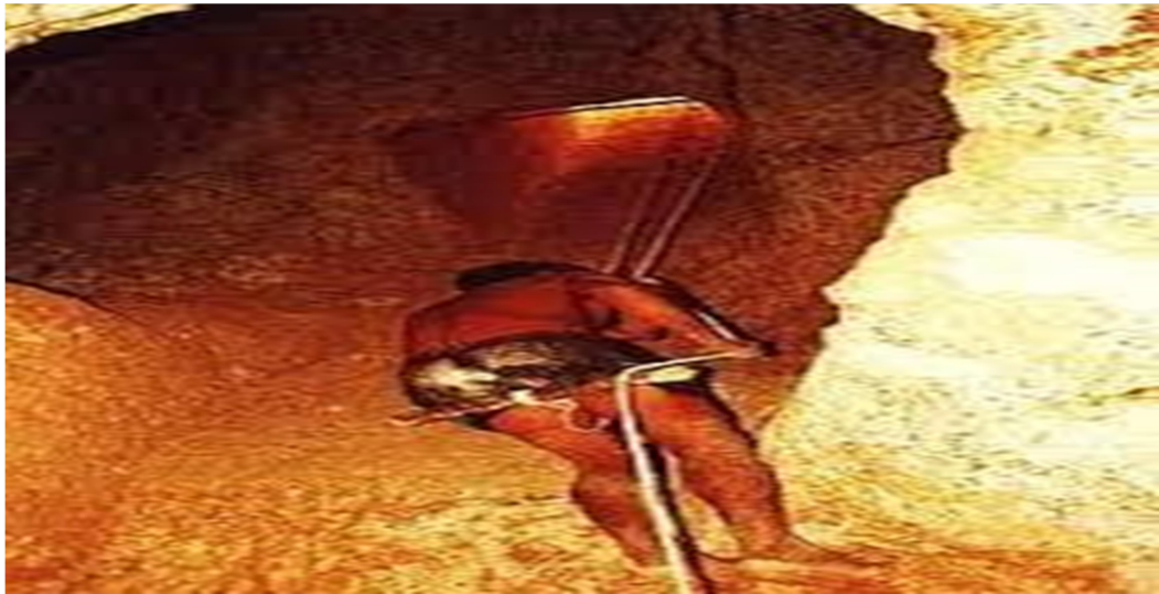
Figura 4: Trabalhadores descendo em banquetas em cordas, uma forma primitiva de descer nos túneis.
