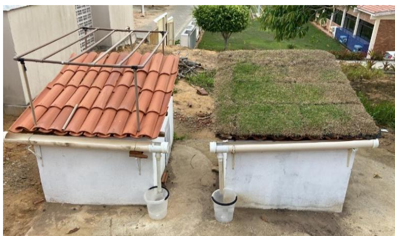
Figura 13 - Execução da camada de vegetação
