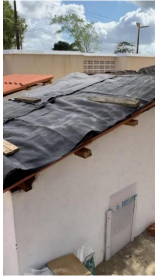
Figura 9 - Execução da camada filtrante
