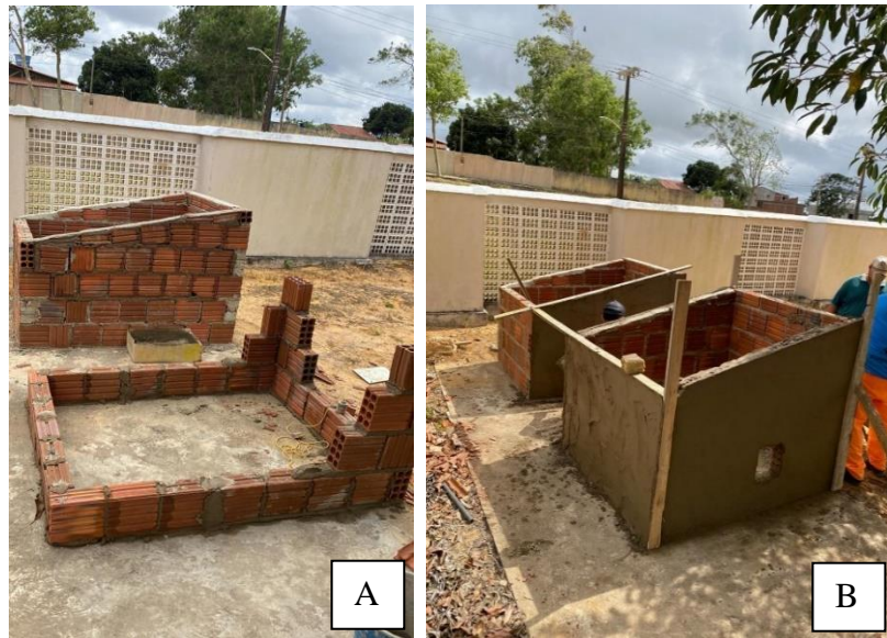
Figura 5 – Estrutura dos protótipos A) Levantamento da alvenaria e B) Etapa de revestimento
