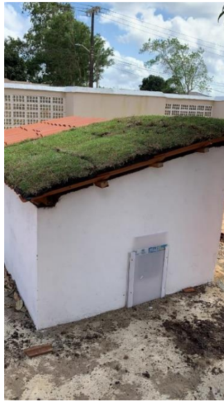
Figura 11 - Execução da camada de vegetação
