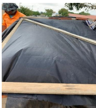
Figura 7 - Execução da camada de regularização
