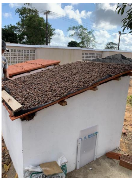
Figura 8 - Execução da camada de drenagem
