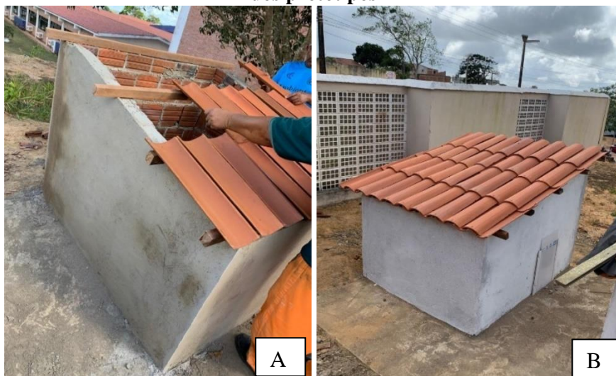
Figura 6 - Cobertura e pintura dos protótipos A) Aplicação das telhas cerâmicas e B) Pintura dos protótipos
