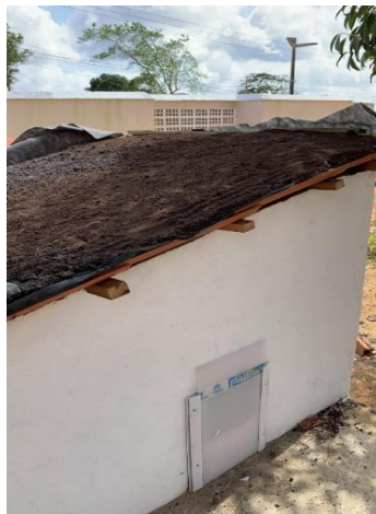
Figura 10 - Execução da camada de substrato
