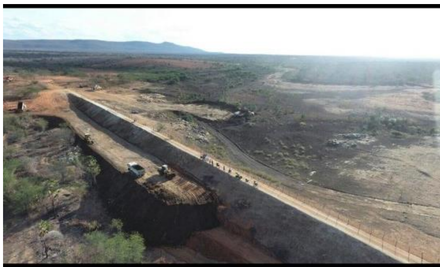
Figura 3: serviços iniciados no Açude do Juá.
