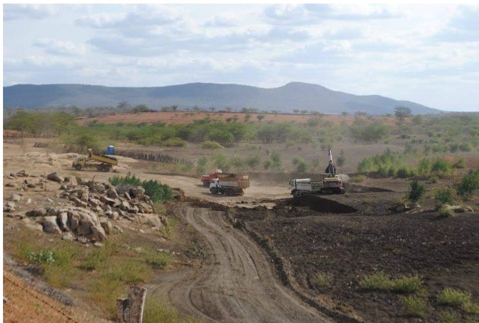
Figura 4: visita dos serviços iniciados no Açude do Juá
