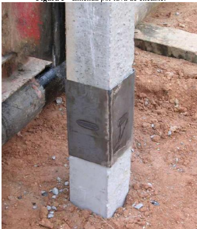
Figura 5 - Emenda por luva de encaixe.
