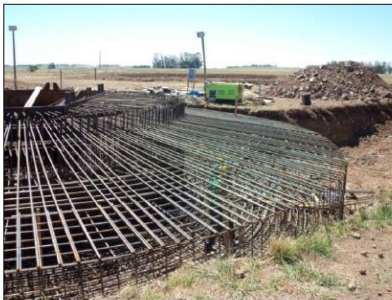
Figura 2 - Sapata circular de uma torre eólica
