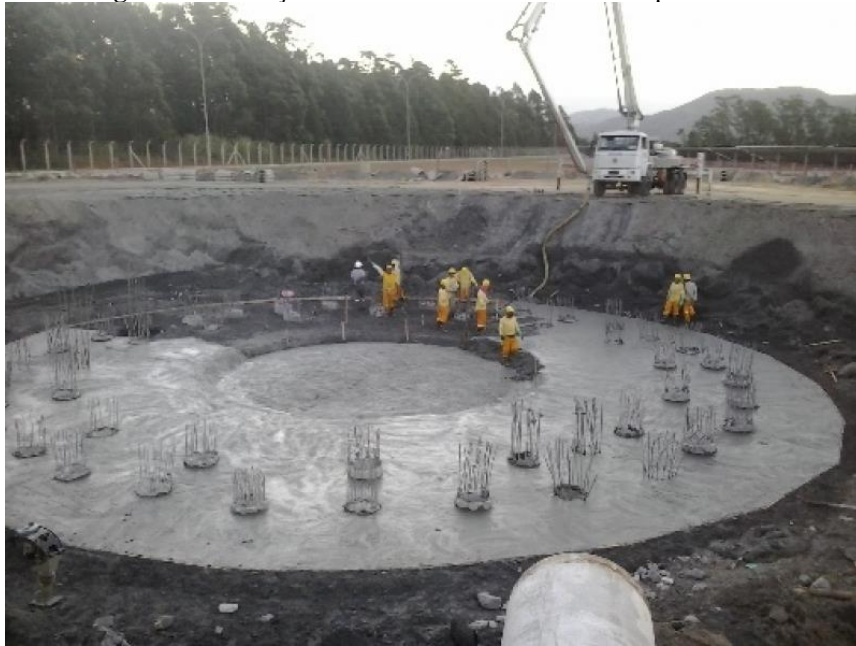
Figura 3 - Fundação de uma torre eólica constituída por estacas.
