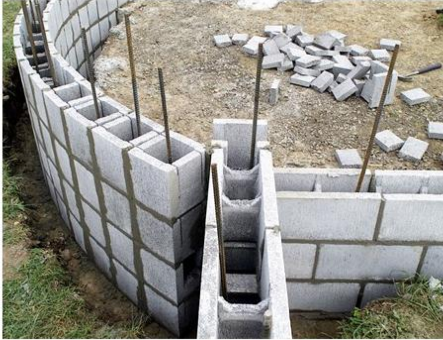
Figura 3 - Alvenaria estrutural armada.
