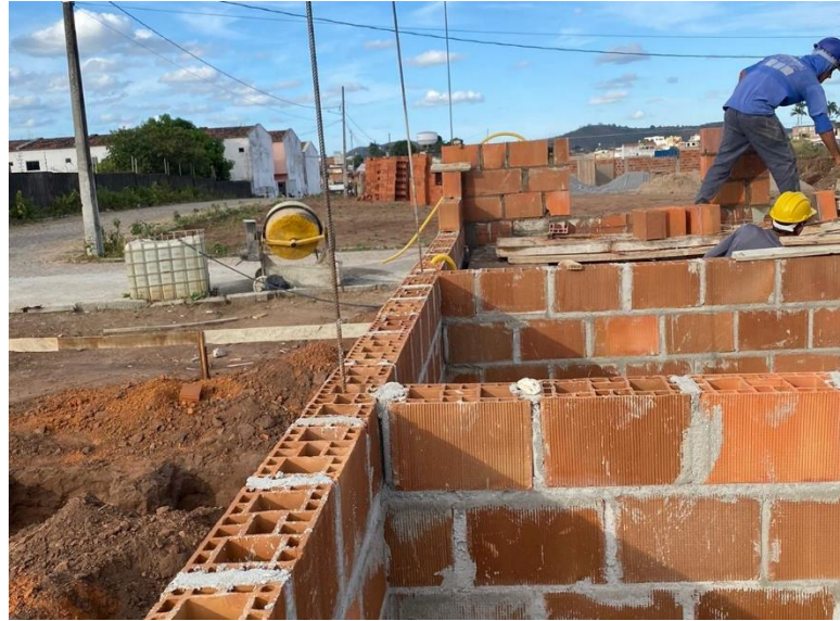
Figura 4 – Residência unifamiliar construída em alvenaria estrutural parcialmente armada.
