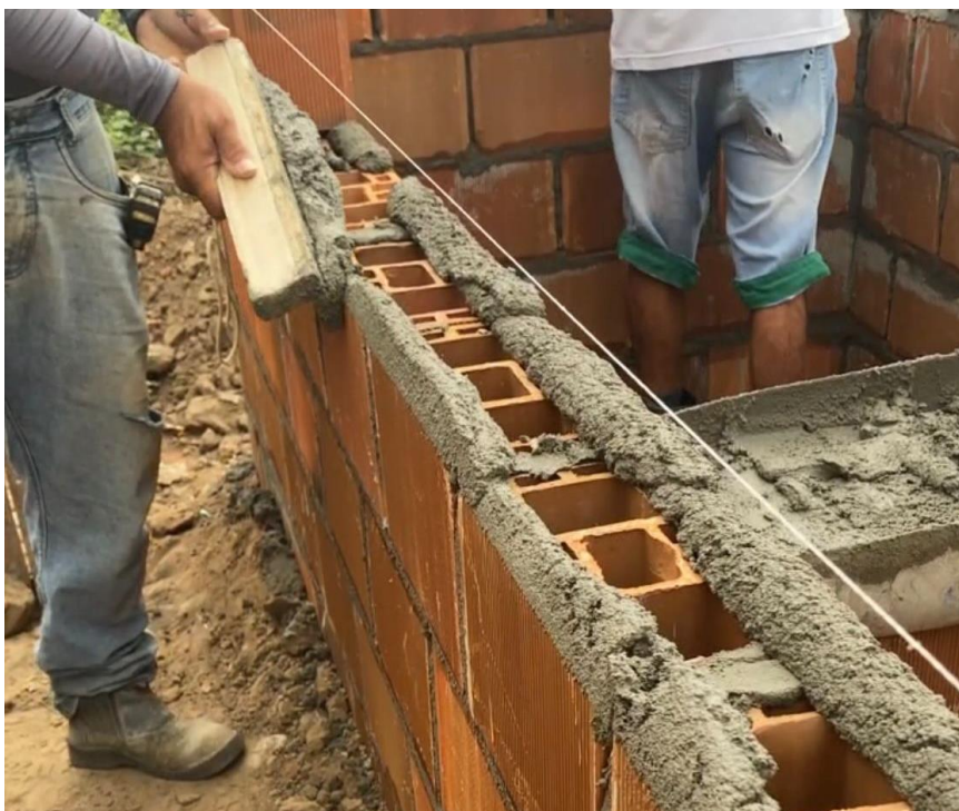
Figura 33 – Assentamento de bloco estrutural com o uso de palheta.
