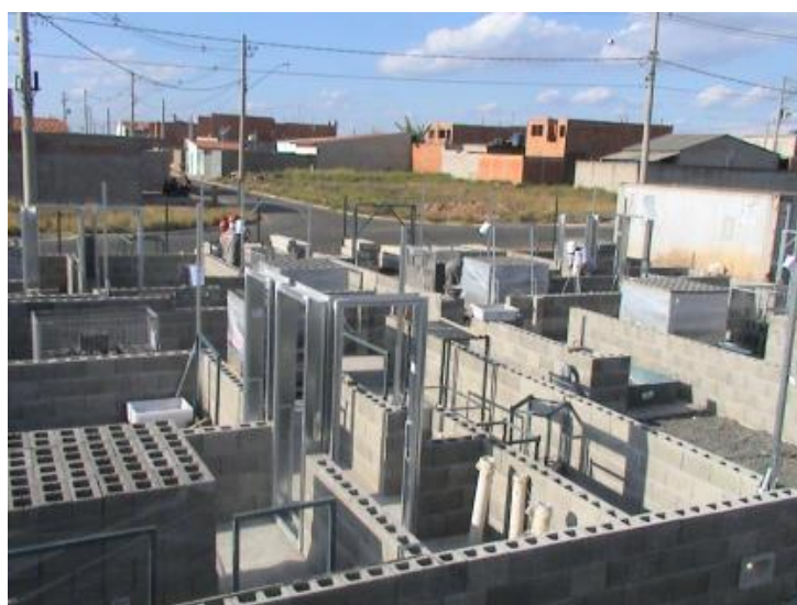
Figura 2 - Edifício residencial em alvenaria estrutural não-armada.
