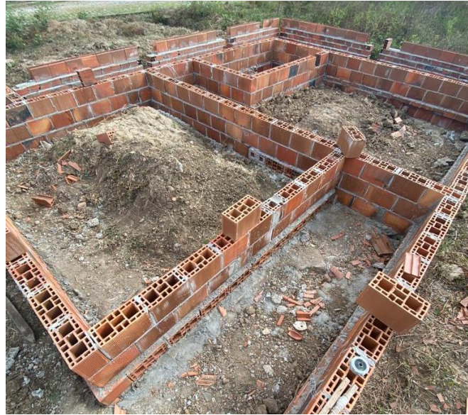
Figura 20 – Execução de alvenaria de embasamento no método de alvenaria estrutural.
