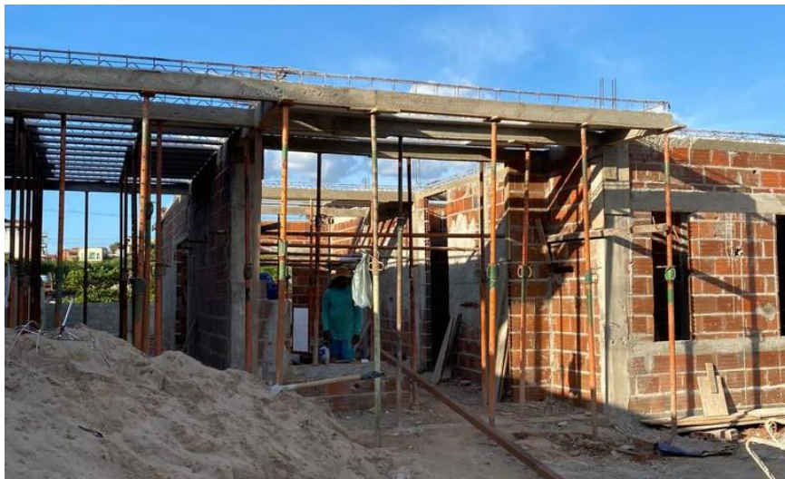
Figura 21 – Execução de residência em alvenaria convencional com presença de vigas e pilares.
