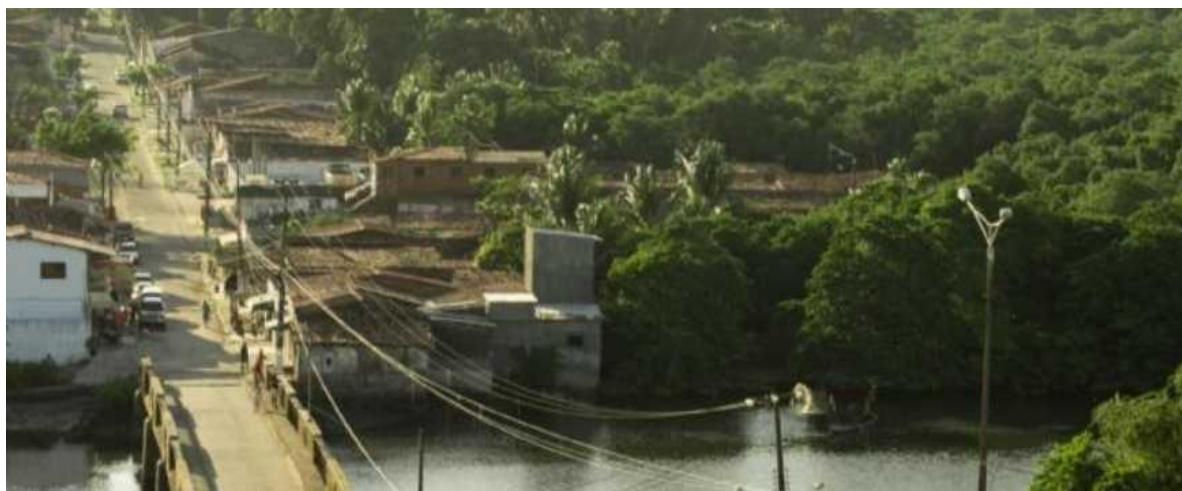
Figura 04: Imagens da Ponte que liga a capital João Pessoa a cidade de Bayeux
