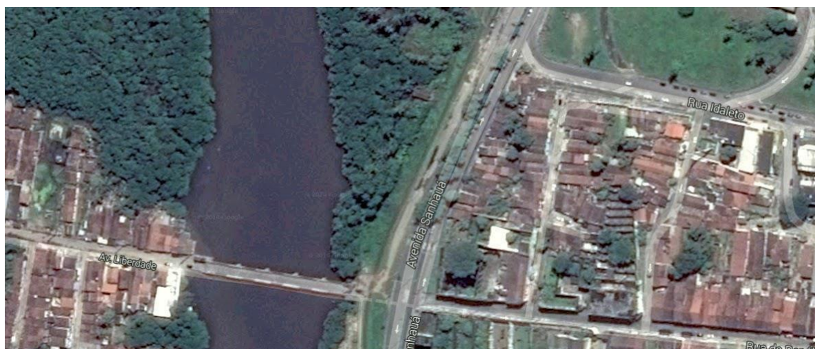
Figura 02: Visão do alto da Ponte do Baralho e do bairro
