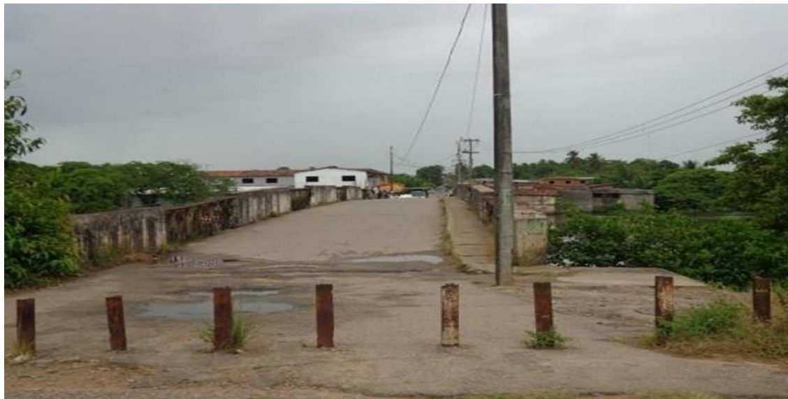
Figura 06: Imagens atuais da Ponte do Sanhauá
