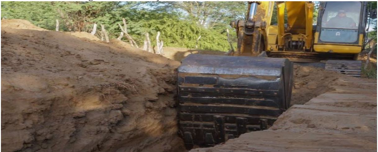
Figura 7 - Construção de adutora em Barra de Santana
