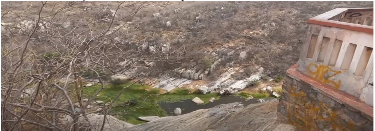
Figura 3 - Ruínas da Barragem Curimatãs no Rio Paraíba
