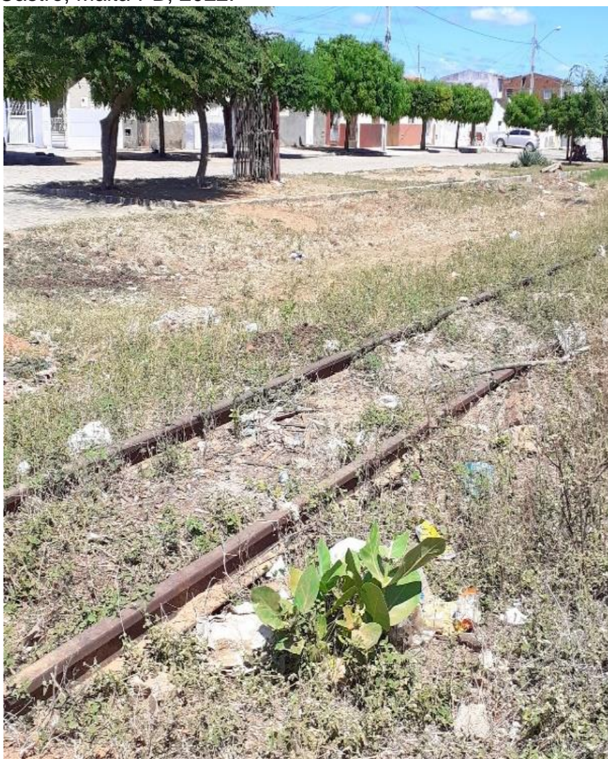
Figura 4 – Acumulação de lixo em via férrea na Rua Doutor Aggeu de Castro, Malta-PB, 2022.
