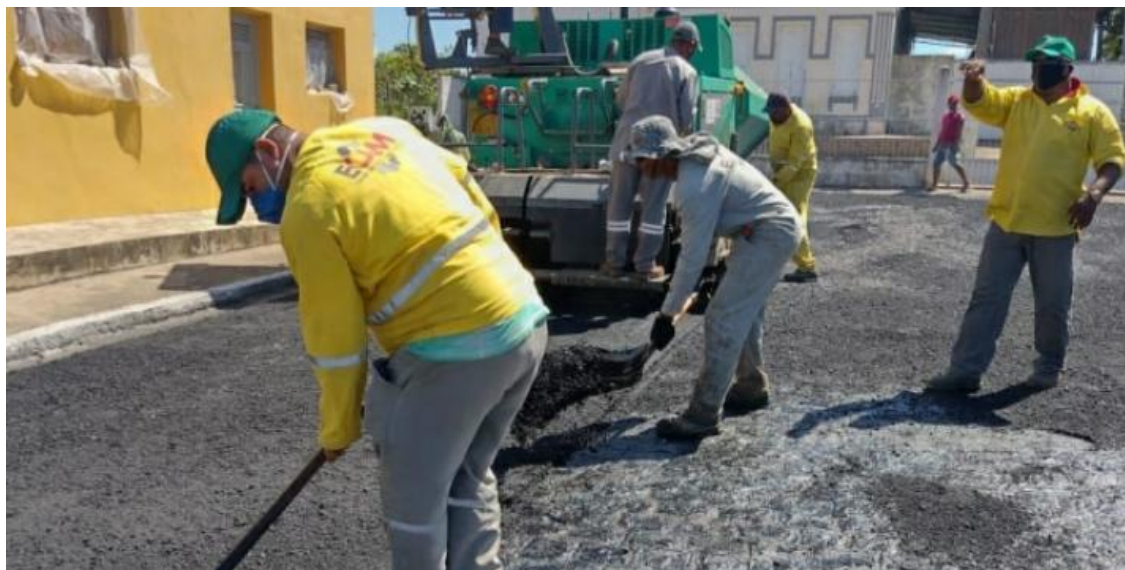
Figura 02 – Asfalto no centro da cidade Itabaiana (Asfalto em Itabaiana ( https://itabaiana.pb.gov.br/site/travessia-asfaltica-de-itabaiana-tem-inicio-e-se-torna-uma-realidade ))
