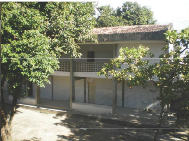
Pátio interno – Bloco de aulas – foto 2
