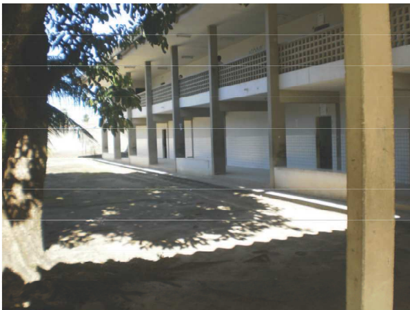
Pátio interno – Bloco de aulas – foto 1
