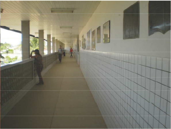
Corredor do Bloco da Administração
