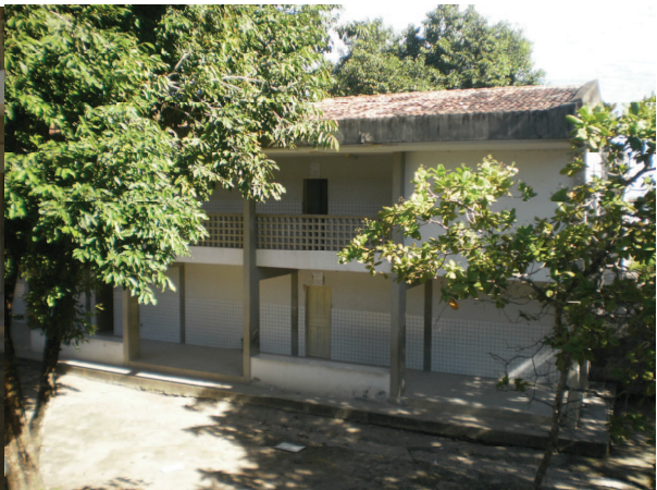
Pátio interno - Bloco de aulas - foto 2
