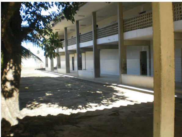
Pátio interno - Bloco de aulas - foto 1
