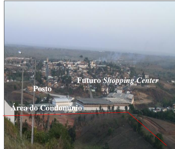
Figura 08 – Área do condomínio e instalações do shopping center , Rua Otacílio Lira Cabral Guarabira/PB
