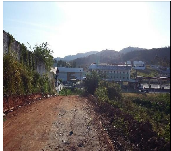
Figura 20 – Abertura da rua Ramalho Barbosa Nunes, bairro Rosário, Guarabira/PB
