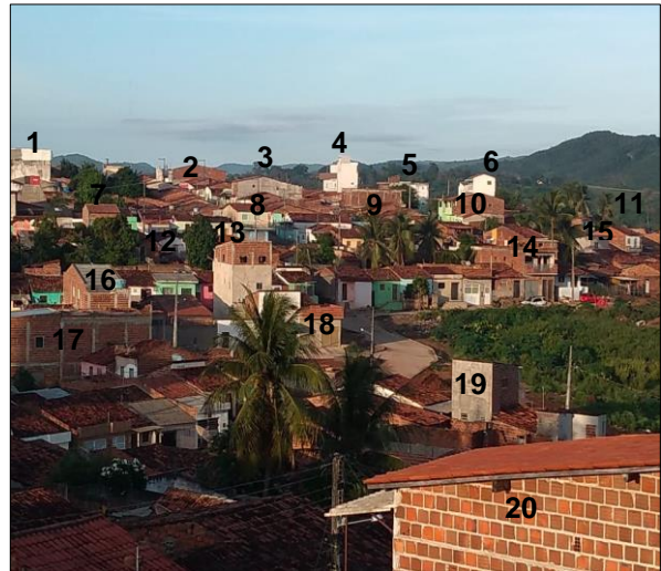
Figura 16 – Vista parcial das submoradias, bairro Rosário, Guarabira/PB
