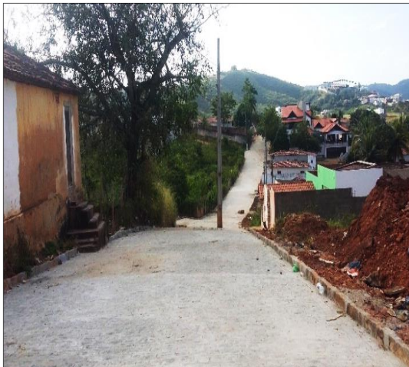
Figura 19 – Pavimentação de rua no bairro Areia Branca, Guarabira/PB
