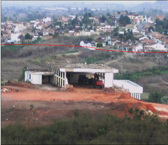
Figura 07 – Antigo Clube, atual Condomínio Serra da Luz Residence Privê , Av. Antônio Paulino Filho, Guarabira/PB
