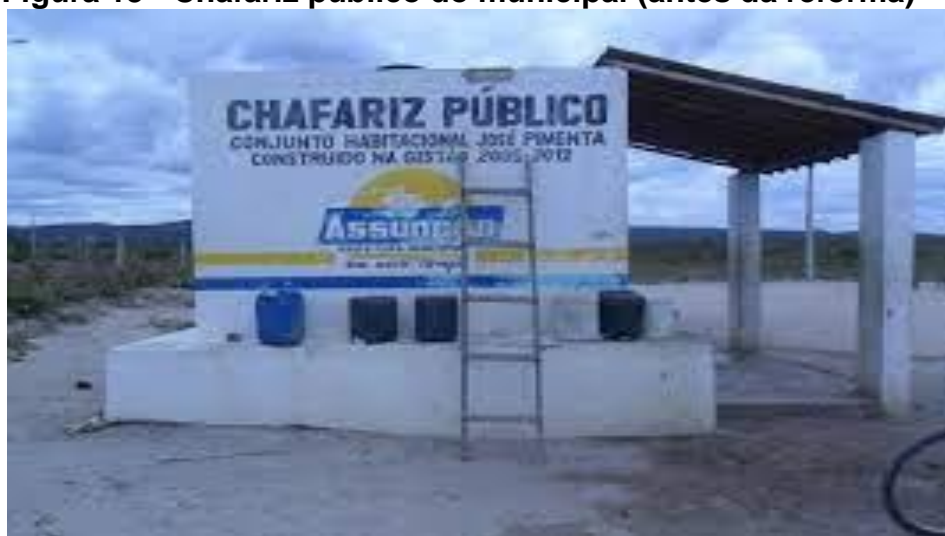
Figura 13 - Chafariz público do municipal (antes da reforma)
