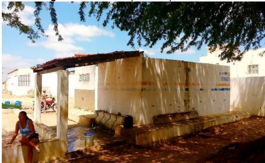
Figura 10 - Chafariz público após a reforma
