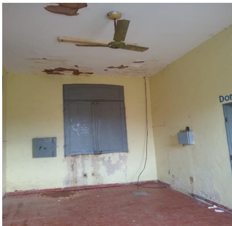
Figura 9 - Compartimento interno que constitui a Estação Ferroviária de Reriutaba, Ceará
