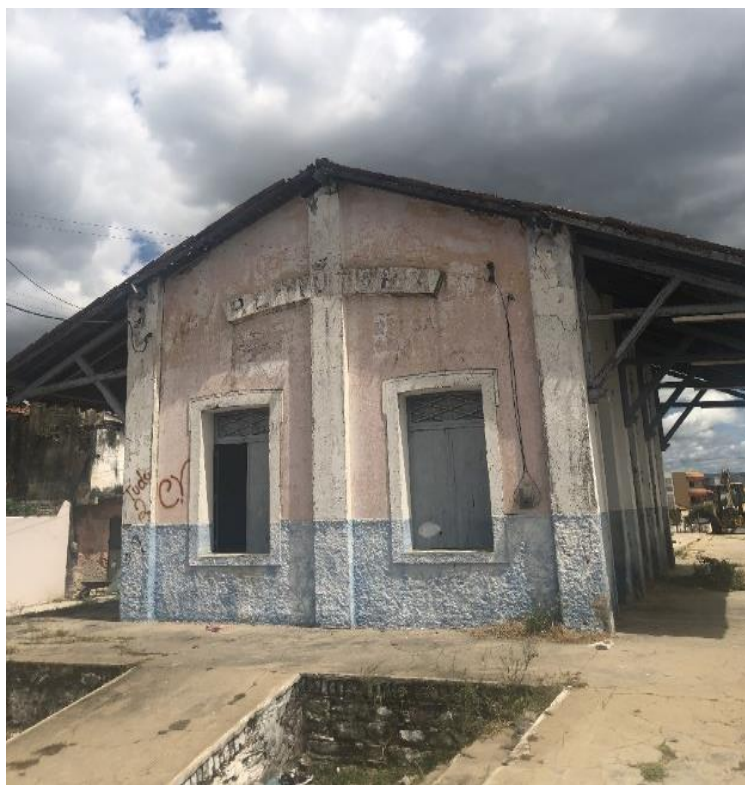
Figura 8 - Fachada da Estação Ferroviária de Reriutaba, Ceará
