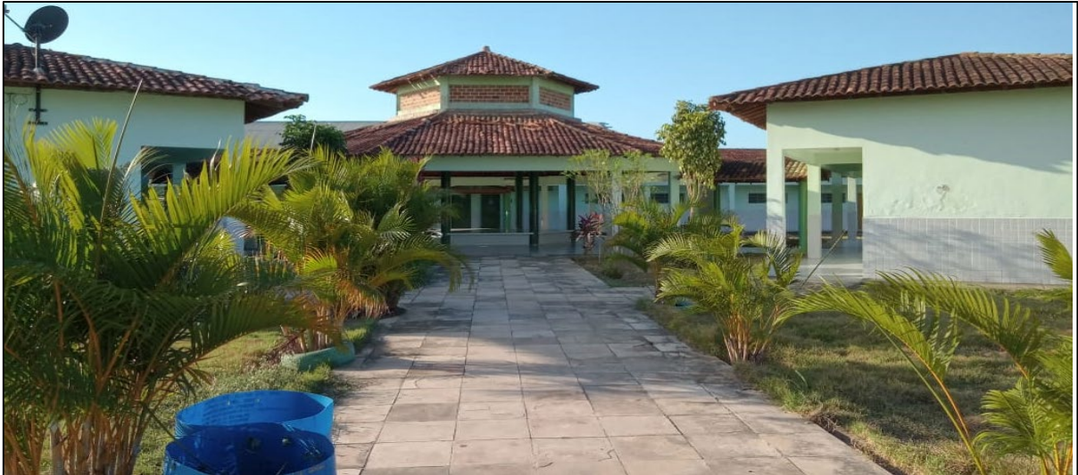
Figura 14 – Estrutura interna da escola Tiradentes.
