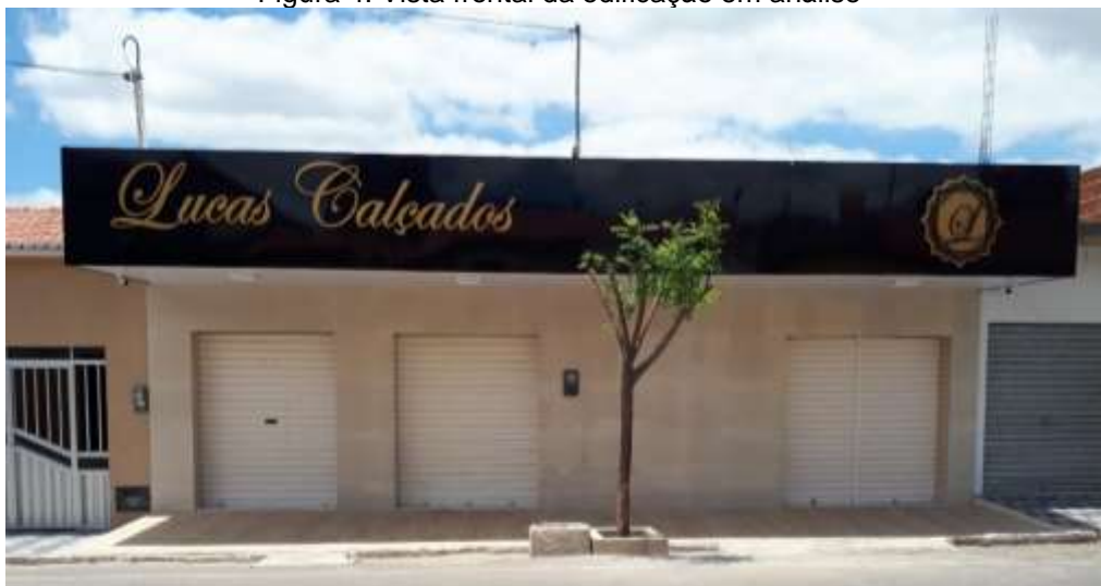
Figura 4: Vista frontal da edificação em análise
