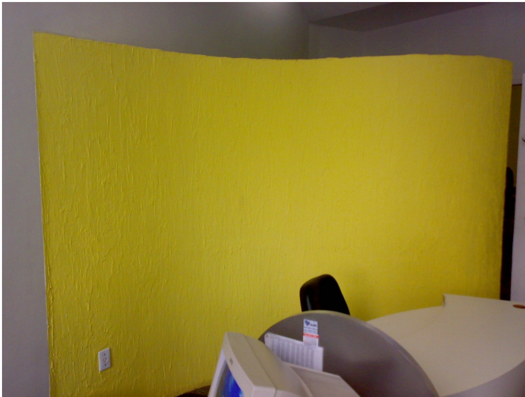
Foto 4 – Parede que dá acesso à sala da gerência
