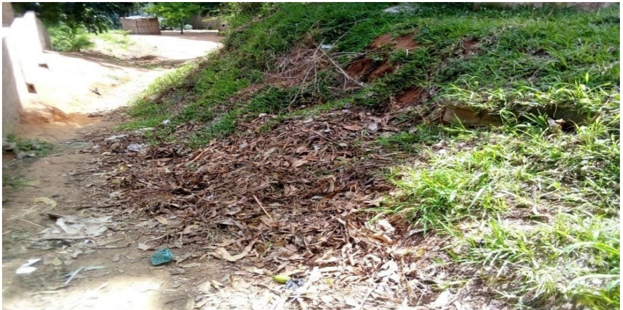
Figura 7 - Deposição de resíduos sólidos em locais de ocorrência de erosão na Unidade 11.
