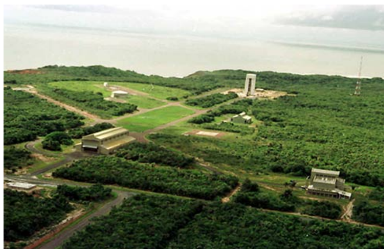
Figura5- Instalações do CLA próximas ao mar
