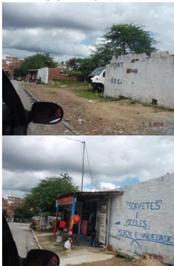
Figura 12 – Ocupações irregulares – Via Férrea
