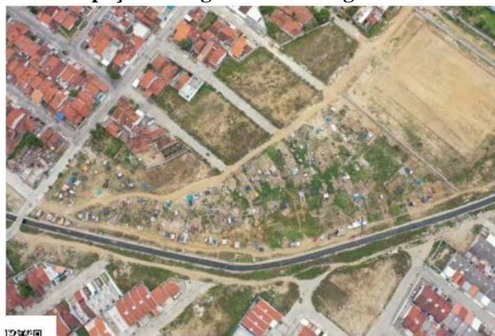
Figura 08 – Ocupações irregulares – Margens do Canal Cruzeiro
