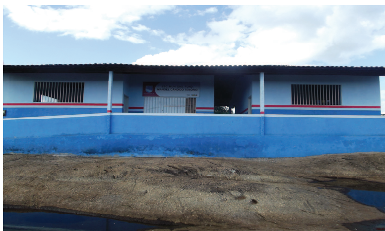
Figura 4: Grupo Escolar Manoel Cândido Tenório Fonte de pesquisa - Junho de 2012
