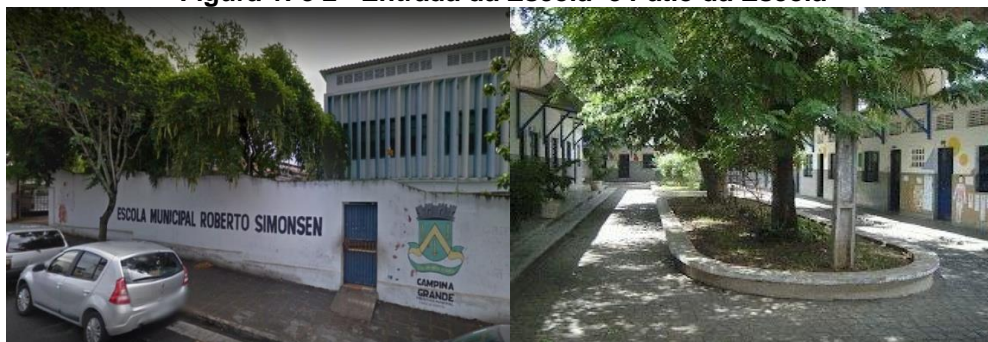
Figura 1: e 2 - Entrada da Escola e Pátio da Escola
