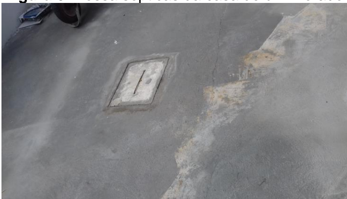
Figura 5- Fossa sépticas da casa de um morador
