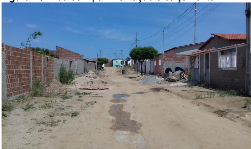
Figura 10- Rua sem pavimentação e calçamento
