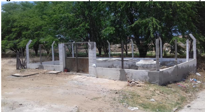
Figura 7- “Fossão” Municipal, destino do esgoto do município
