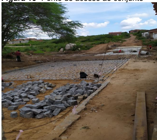
Figura 13- Ponto de acesso ao conjunto
