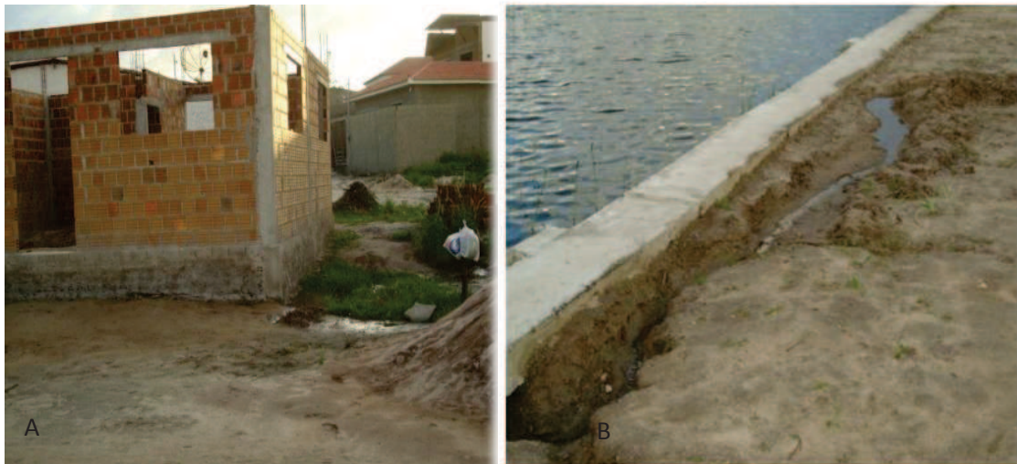
Figura 28: Construções de casas as margens da Barragem com o risco de infiltração
