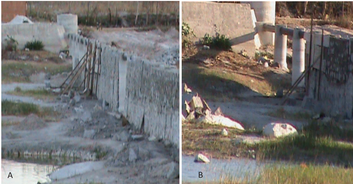
Figura 21: Construção dos dutos de drenagem dos esgotos
