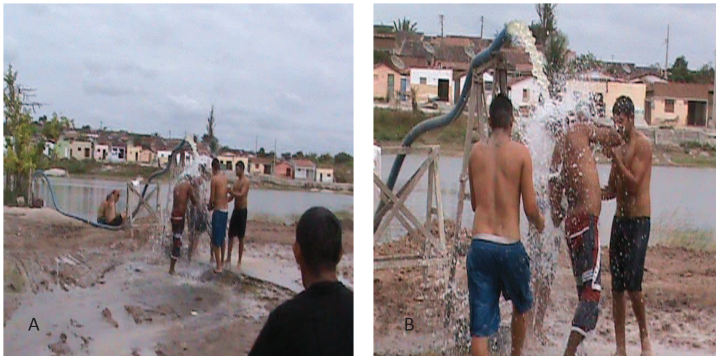
Figura 22: Drenagem das águas da Lagoa Barragem
