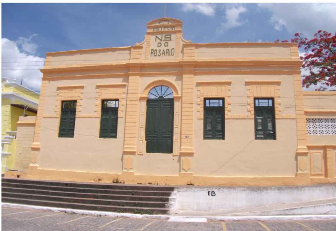
Figura 2: Fachada do antigo auditório do colégio.
