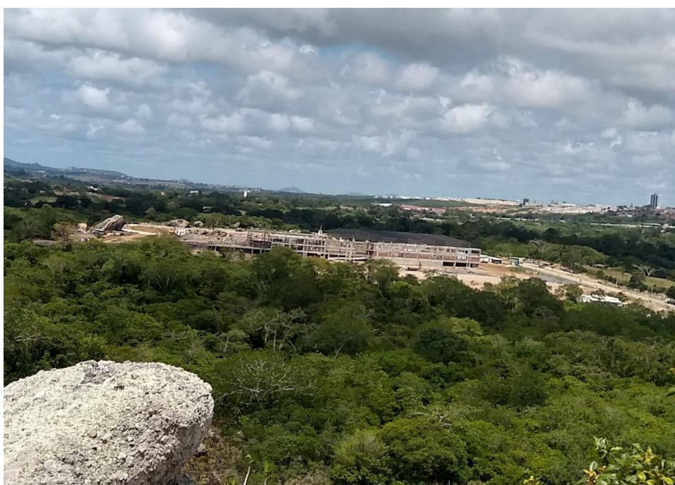
Figura 14- Obra do Centro de Convenções no interior do PNMSB.
