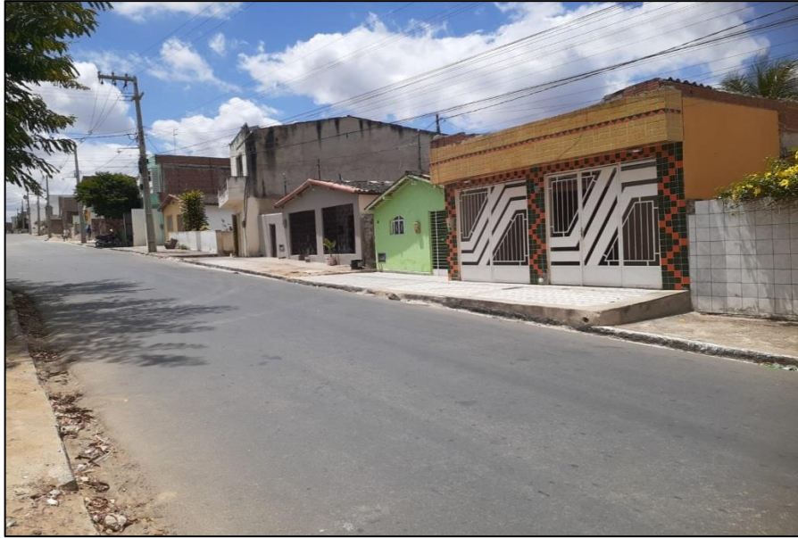
Figura 3 - Instalação da rede pública no setor II
