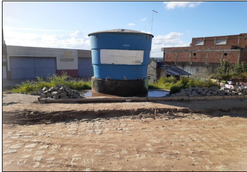
Figura 1 - Caixa d' água
