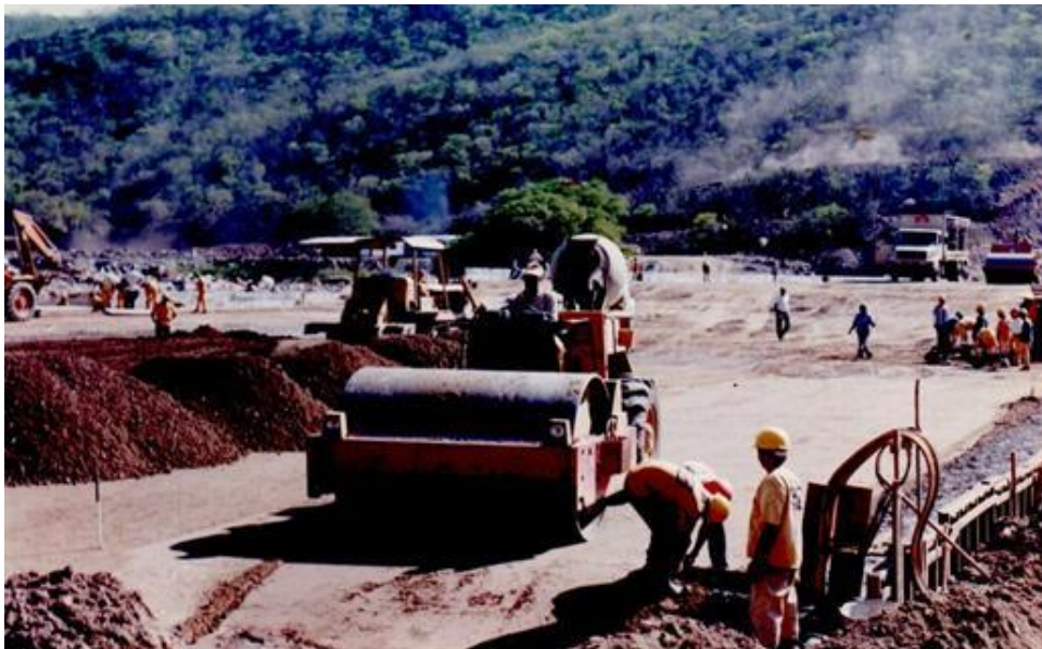
Figura 1 –Fase de construção da barragem.
