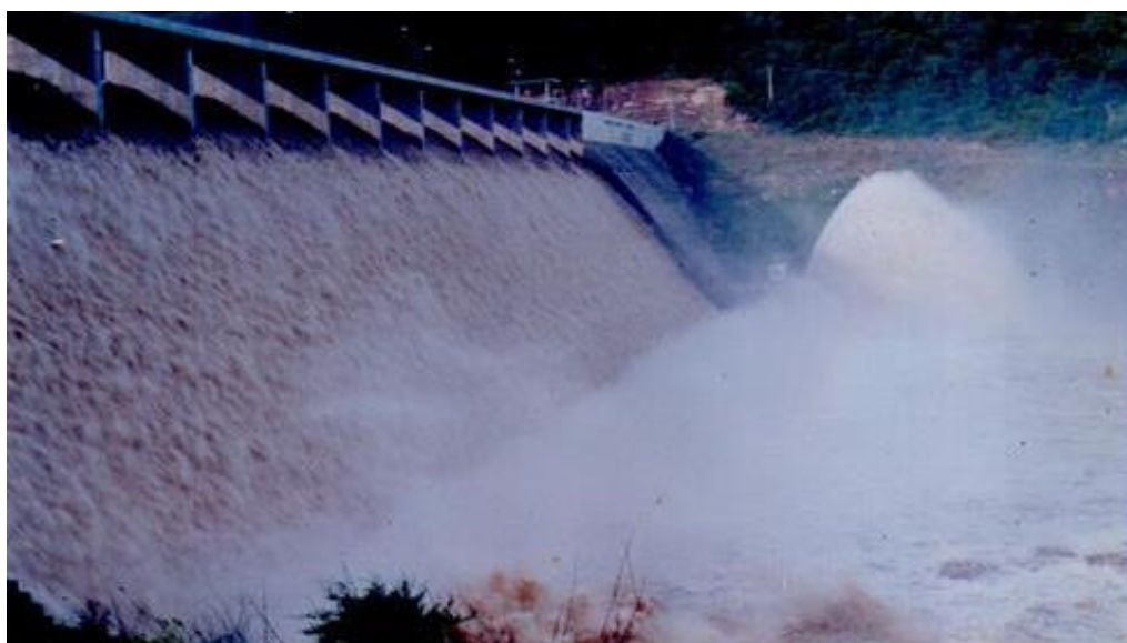
Figura 4- Sangria da barragem.
