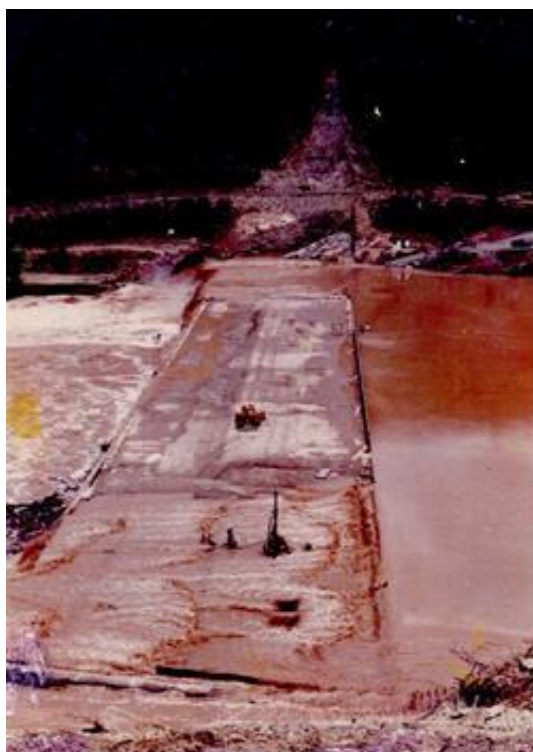
Figura 2- Fase de construção da barragem
