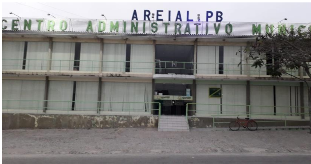
Figura 12: CENTRO ADMINISTRATIVO MUNICIPAL
