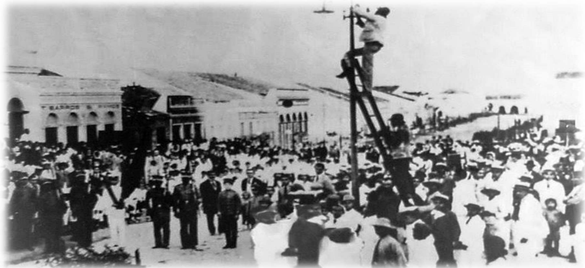
Figura 2: Instalação do primeiro ponto de luz elétrica em CG
