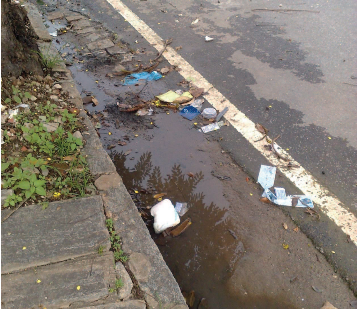
Figura 22 – Água suja acumulada em meio aos resíduos sólidos espalhados (Stº Antônio). Fonte: CHAVES, Elaine Araújo. Pesquisa de campo, 05/2011.
